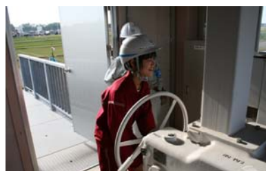
藤山樋管にてゲートの手動操作体験
