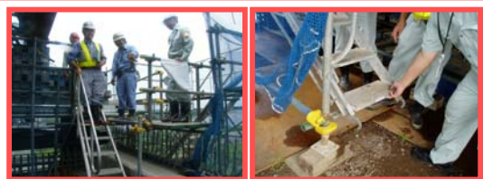
庄内中央大橋上部工工事にて
