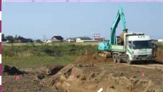
掘削した土砂を積込んで余目・酒田道路の工事に使用します。
