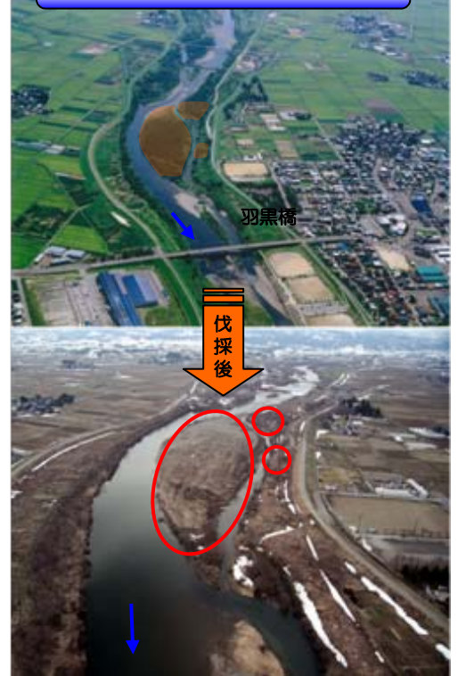
赤川我老林地区河道掘削工事
