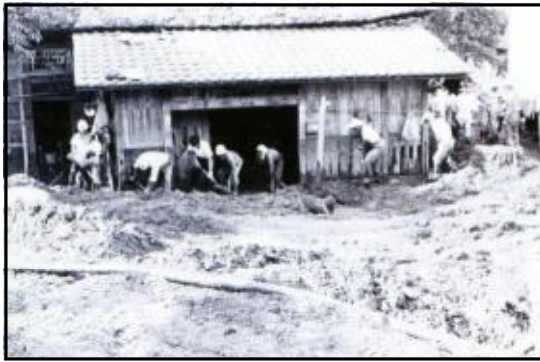
被災状況:S46.7 洪水(旧朝日村行沢地区)
