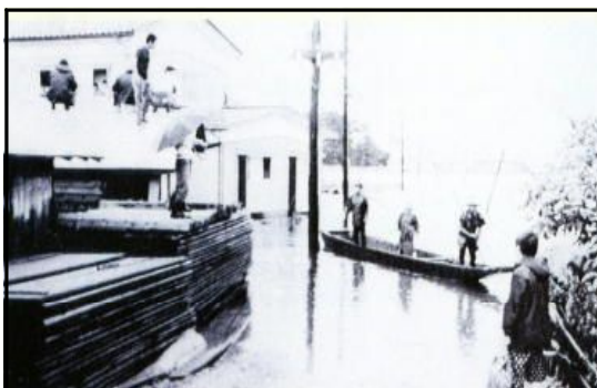
被災状況:S44.8洪水(鶴岡市宝町地区)
