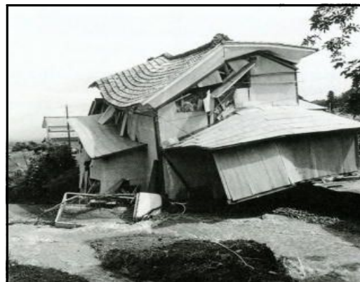
被災状況:S46.7 災害(旧朝日村越中山地区)
