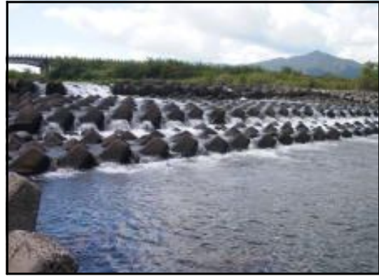
魚類遡上支障の床止
