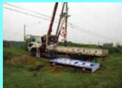
支障物件 (看板) の撤去
