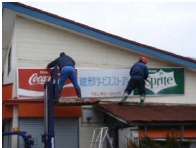
①看板の撤去
