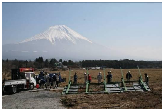
平成 19 年度民間・市の看板など6基の撤去
