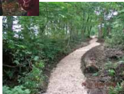
フットパス(点検路)の整備
