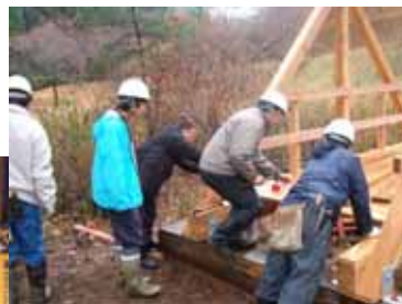
木の香る道づくり (木橋架設)
