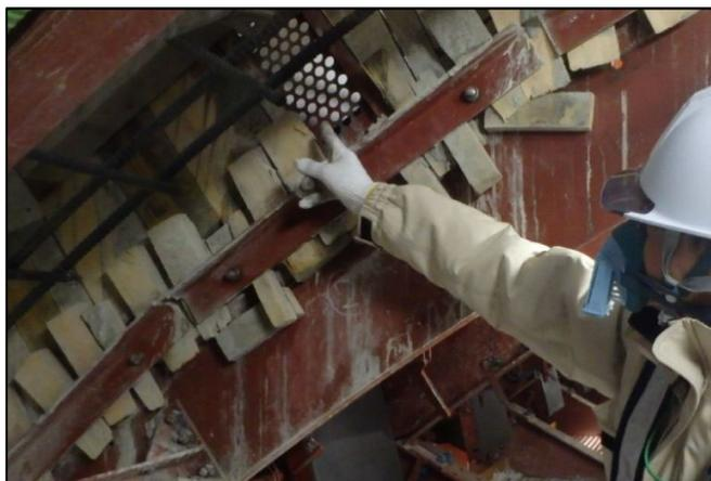
写真 6-20 パンチングメタルの設置状況
