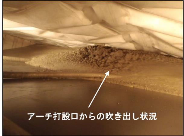
写真 6-4 アーチ打設口からの打込み (終盤)
