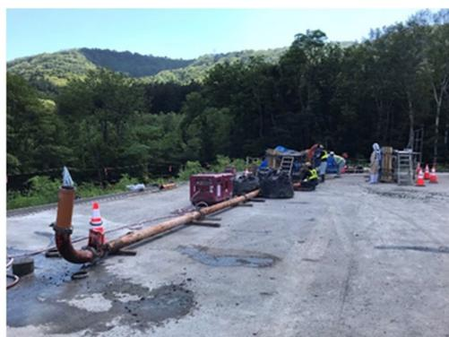
写真 打込み用配管 (約 30m)
