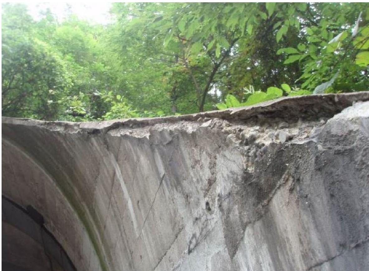
写真 1-15 トンネル坑口の凍害による劣化
