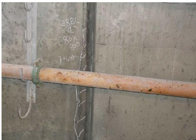
写真 6-25 側壁部に発生したうき
