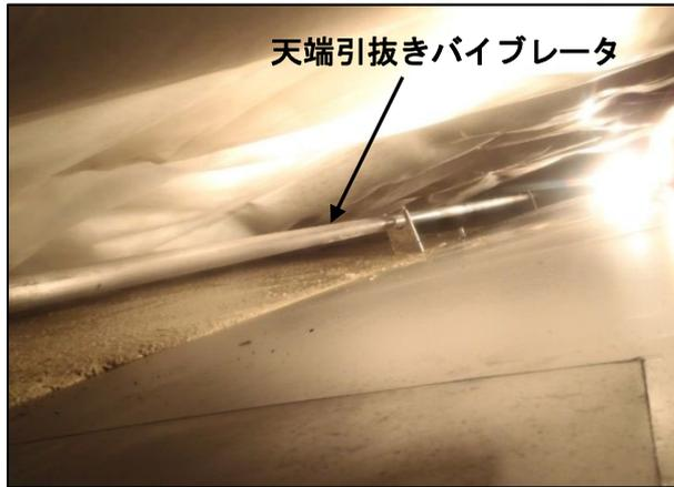
写真 6-5 アーチ打設口からの打込み (完了)
