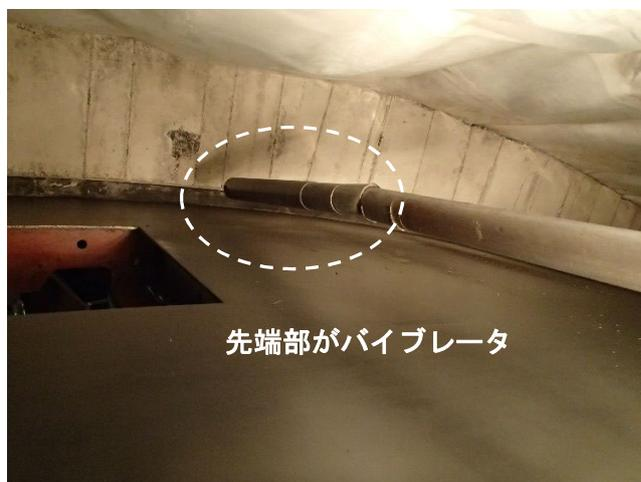
写真 6-8 天端引抜きバイブレータ
