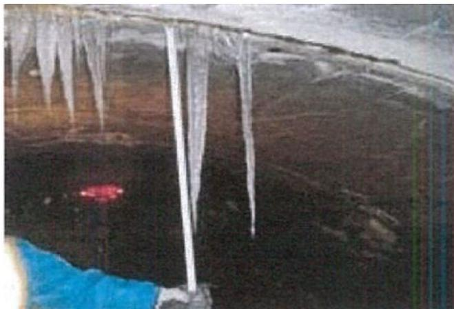
写真 6-33 覆工面（施工目地部）の漏水（氷柱）
