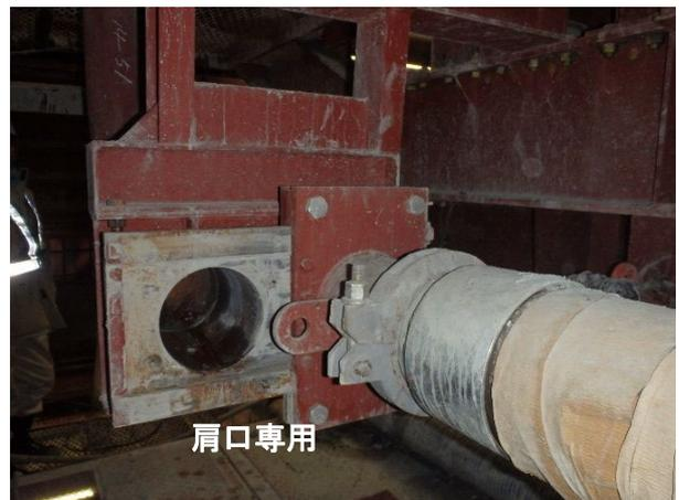
写真 6-7 打設配管切替えシステム
