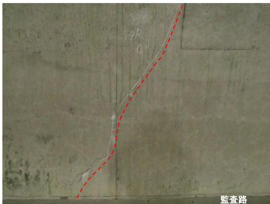
写真 1-8 側壁の横断ひび割れ
