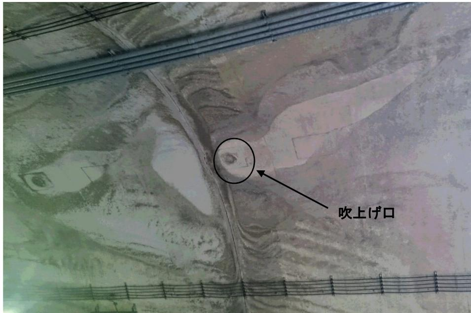
写真 1-5 天端部の色むら・アーチの打重ね線
