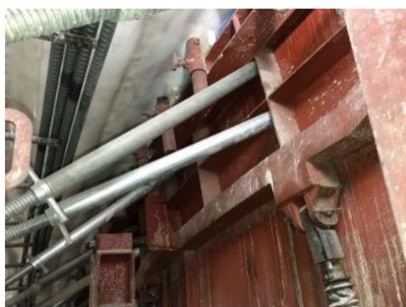
写真 6-28 鋼製つま型枠の採用例
