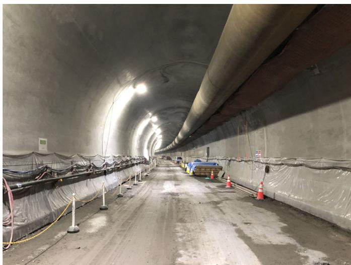
写真6-2 SL下の側壁のビニールシートを用いた長期養生の事例
