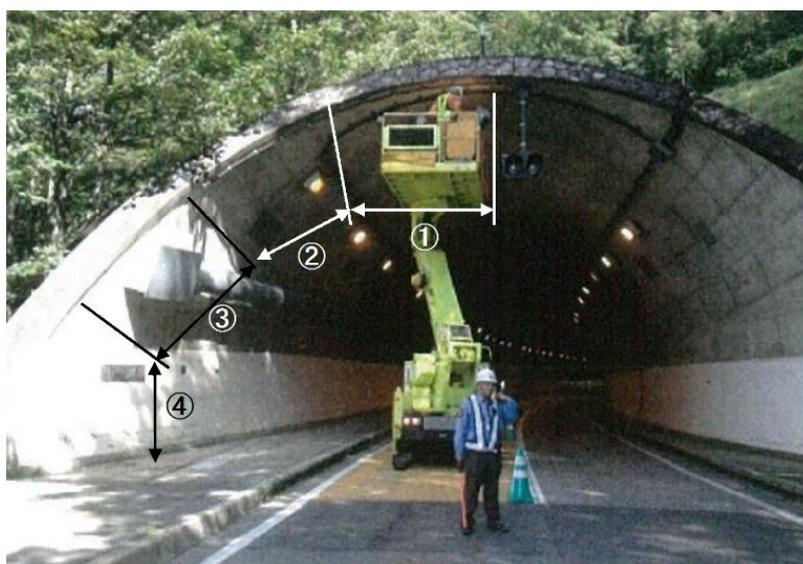
写真 7-1 高所作業車による打音点検状況
