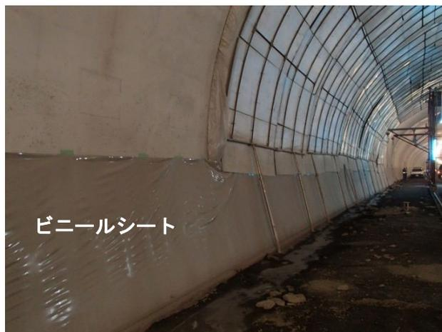
写真 6-4 保湿養生（側壁部の長期養生）
