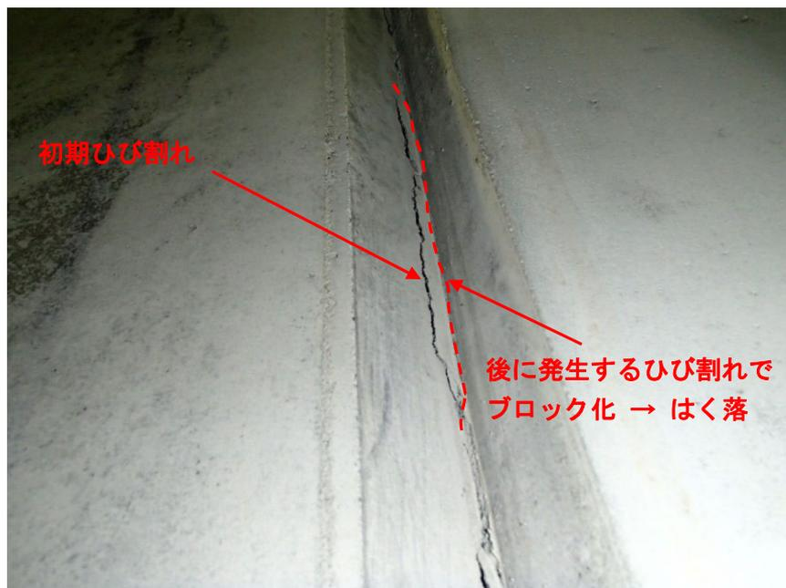
写真 6-22 施工目地部のひび割れ発生状況
