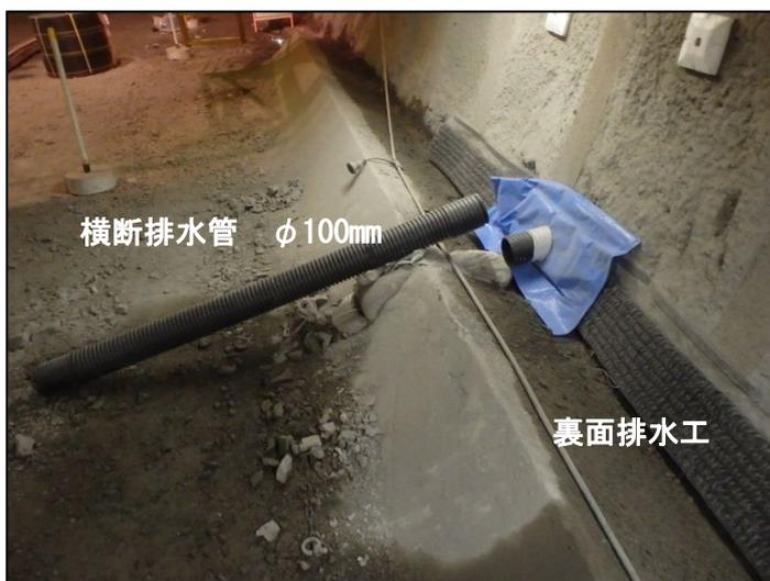
写真 6-39 横断排水管の増設（施工途中）
