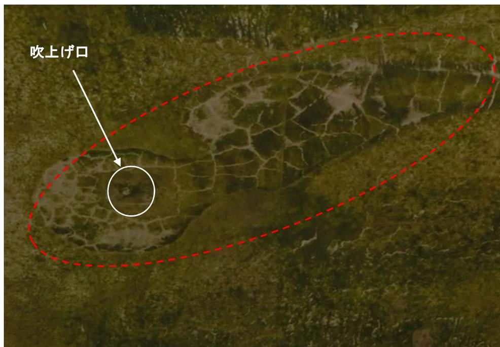
写真 1-7 吹上げ口付近で色むら沿いに発生した亀甲状ひび割れ
