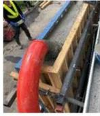
模擬型枠端部に設けた生コンクリートの投入口
