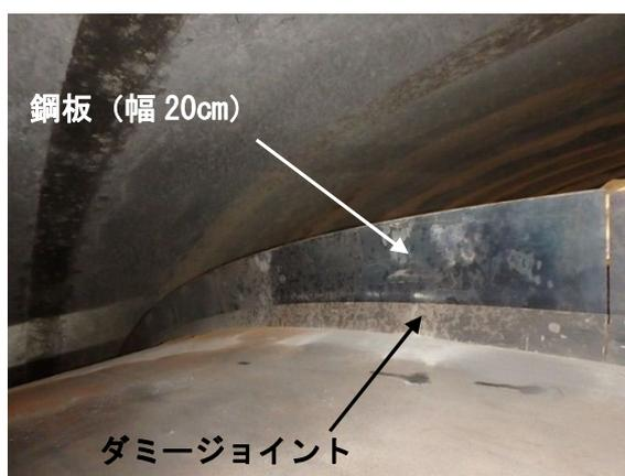
写真 6-27 目地部への鋼板設置状況
