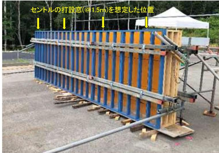
センターの側壁部分を模した型枠(幅0.3m、高さ1.5m、長さ5.0m)
