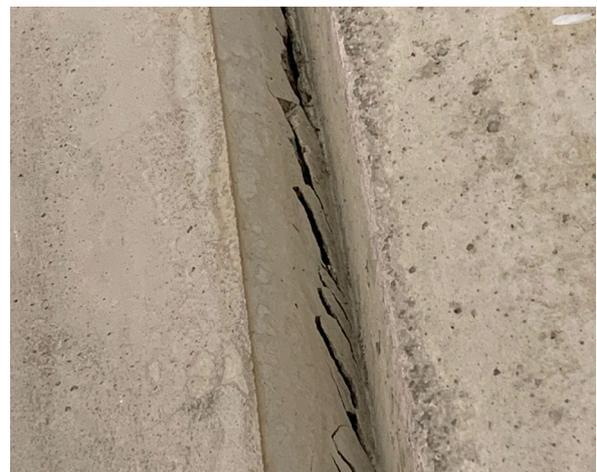
写真 1-17 コンクリートの収縮による開きで生じたと思われる目地部でのひび割れ
