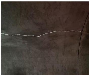
⑦天端部の縦断方向ひび割れ
