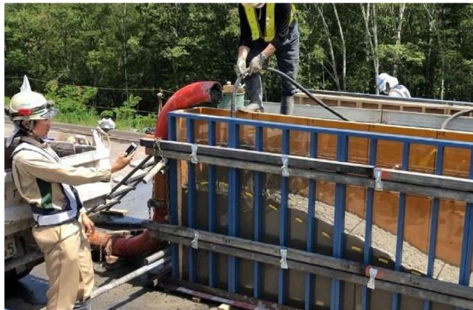
写真 6-12 1 層目、締固め時間管理
