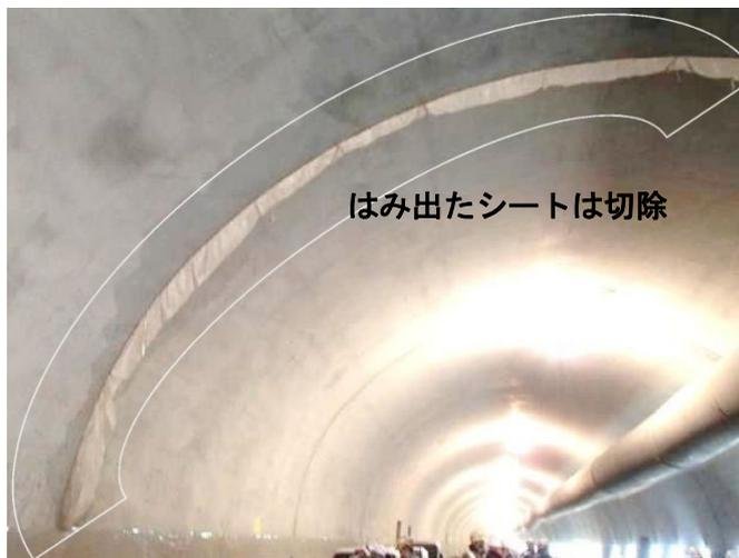
写真 6-24 施工目地へのビニールシート設置状況（脱型後）
