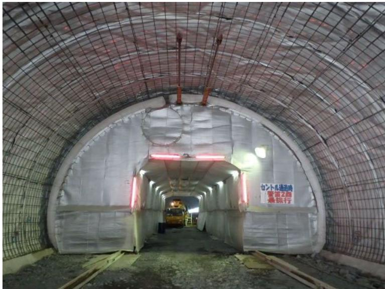
写真 6-5 保温養生（移動型枠全体を覆う）
