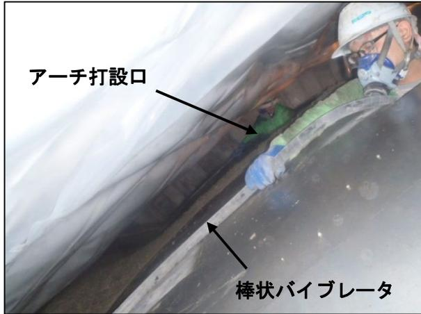
写真 6-3 アーチ打設口からの打込み
