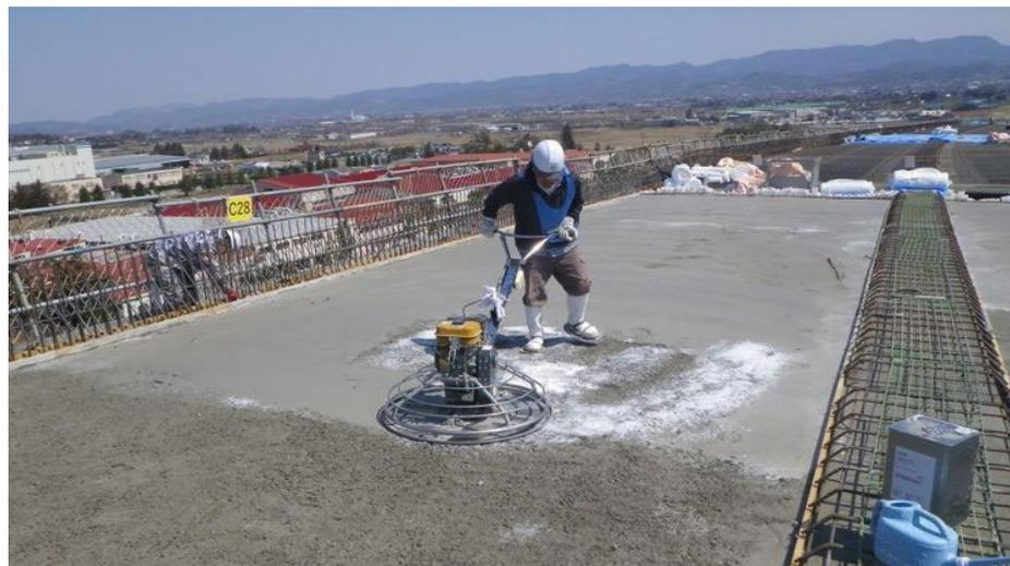
図3-⑤ 単位水量約  $160\text{kg/m}^3$  のコンクリートの仕上げ状況
