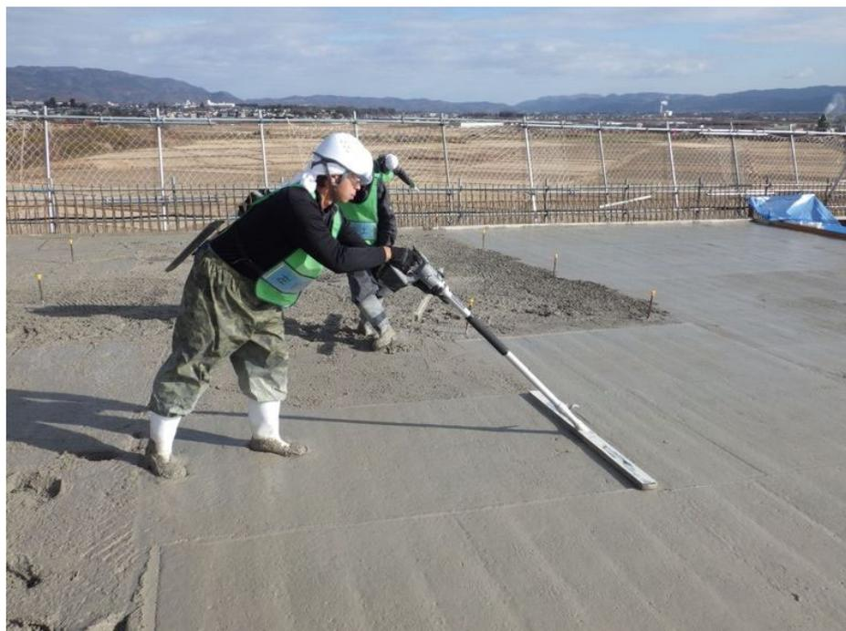
図3-⑥ 単位水量約  $170\text{kg/m}^3$  のコンクリートの仕上げ状況
