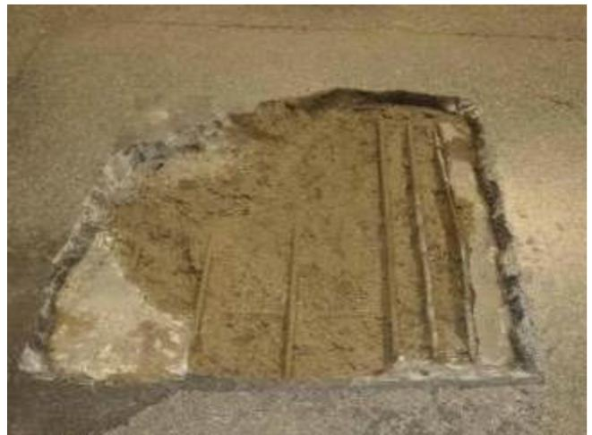
写真1-③ RC床版の土砂化の事例
