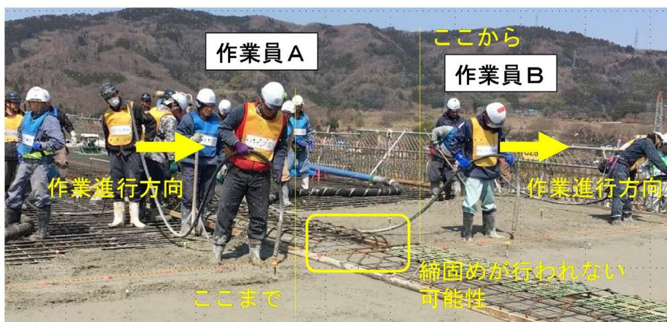
写真7-㉓ 中央分離帯がある場合の床版の締固め状況 (その1)
