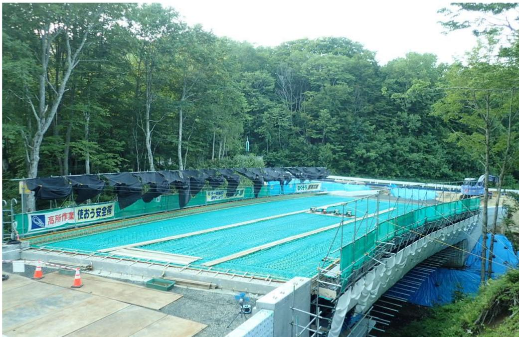
写真7-⑭ エポキシ樹脂塗装鉄筋の採用例
