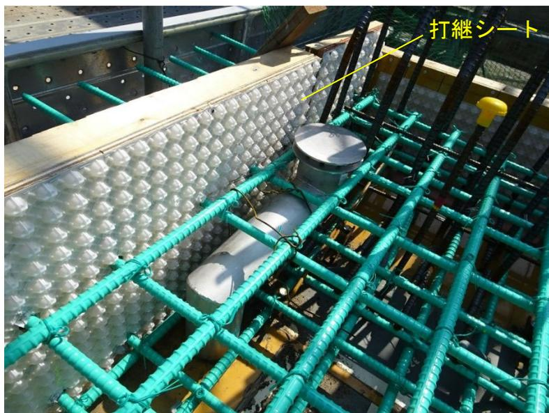
写真6-1-⑪ 打継目の処理（打継シート）の例
