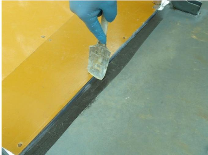
写真7-⑱ 型枠目地のシーリング例
