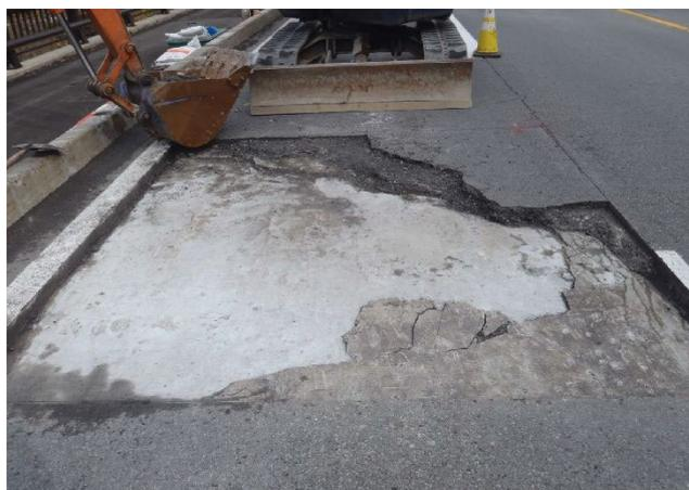
写真12-② 調整モルタルの割れ
