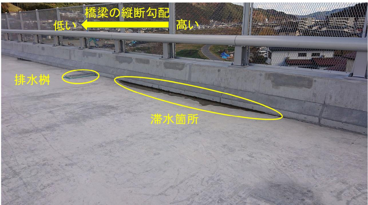
写真6-1-⑦ 床版上面に生じた平坦性不良による滞水
