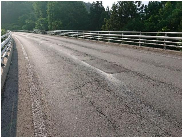
写真1-⑨ 舗装の施工ジョイントから水が浸入し土砂化が発生した事例
