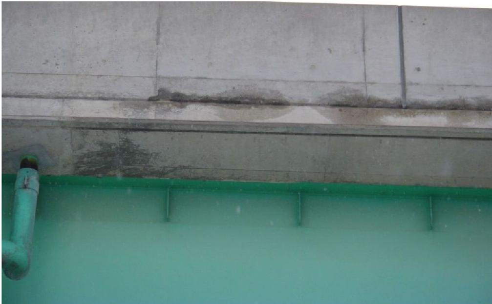
写真6-1-⑫ 地覆打ち継ぎ目部からの漏水
