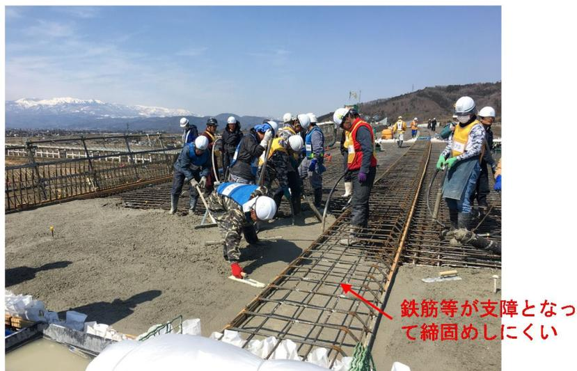
写真7-⑳ 中央分離帯がある場合の床版の施工状況
