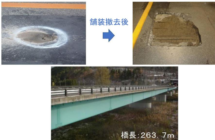
写真1-⑫ 床版の土砂化により緊急打換えを実施した橋梁
