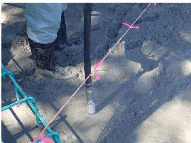
写真7-㉒ マーキングロープの活用例 (50cm 間隔による締固め)
