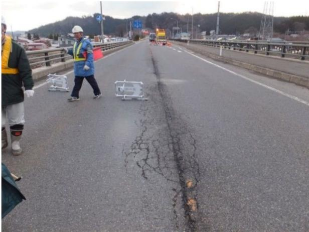
(a) 舗装目地部の路面ひび割れ
