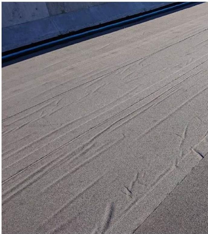
写真1-⑭ 空気泡やヨレなどによりシート防水の貼り直しが必要となった事例
