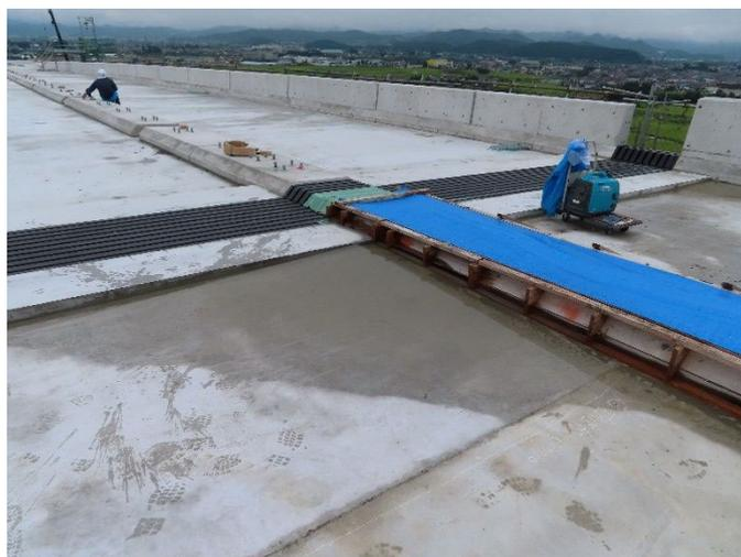
写真5-⑥ 伸縮装置の後打ちコンクリートと中央分離帯の基礎コンクリートが接している場合の滞水事例
