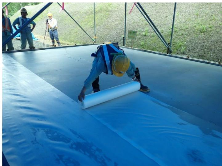
写真6-2-⑰ 湿潤養生マットの適用性を確認
