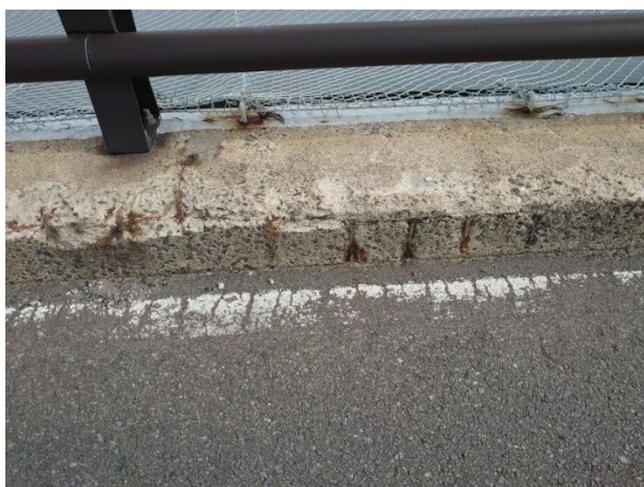
写真1-⑩ 地覆の鉄筋腐食区間から床版への水の浸入が懸念される事例
