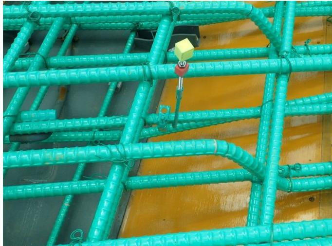
写真7-⑯ 天端表示金具を樹脂被覆した例
