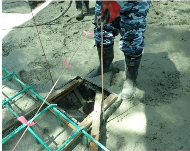
写真7-⑳ 路面排水柵下面の気泡抜き例（紐による気泡抜き）
