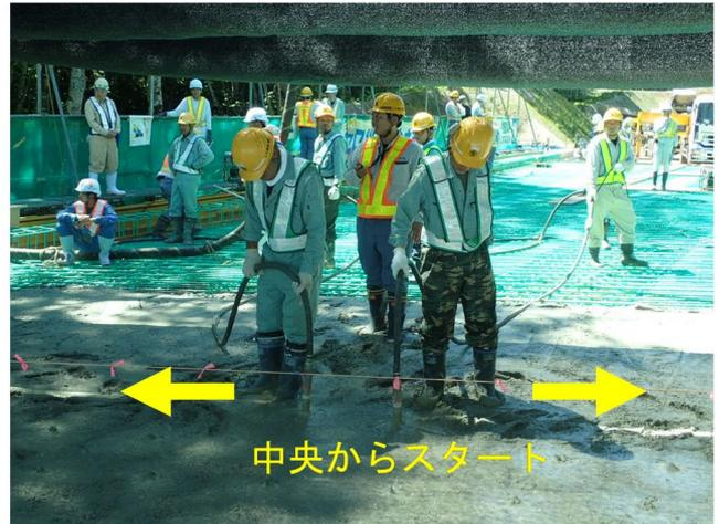
写真7-③④ 中央分離帯がある場合の床版の締固め状況（その2）
