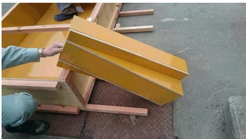
写真6-2-⑤ 型枠でつくった模擬排水柵
