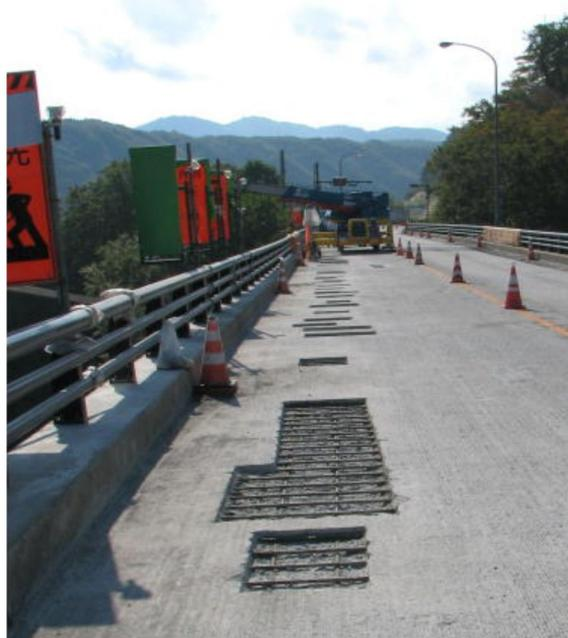
写真1-⑦ タイヤの走行軌跡に沿った変状(変状部分を除去した状態)
