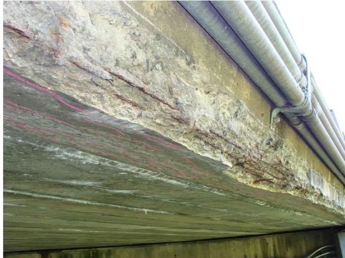
写真1-⑳ コンクリート橋の外桁下部に凍害を含む劣化が生じた事例
