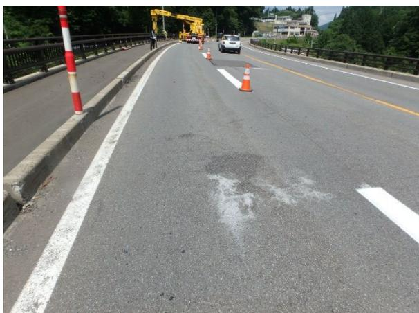
写真12-① 舗装上面の析出物
