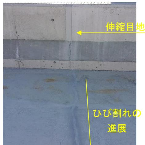
写真5-① 壁高欄の目地部からRC床版上面に進展したひび割れの事例（上面）
