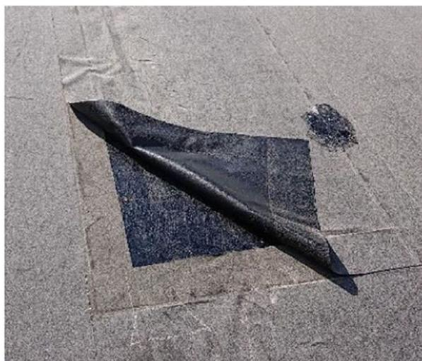
シート敷設後から時間が経過した場合やシートのヨレや空気泡が多い箇所では、風などの影響によりシートの重ね継手部分からはがれてしまう。シートの端部を加熱アスファルトで補修し防水しないと漏水の原因となる。
