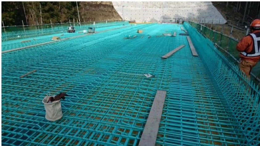
写真7-③ エポキシ樹脂塗装鉄筋の採用例
