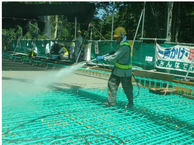
写真7-㉑ 高圧洗浄機による打継ぎ面の散水(湿潤状態の確保)
