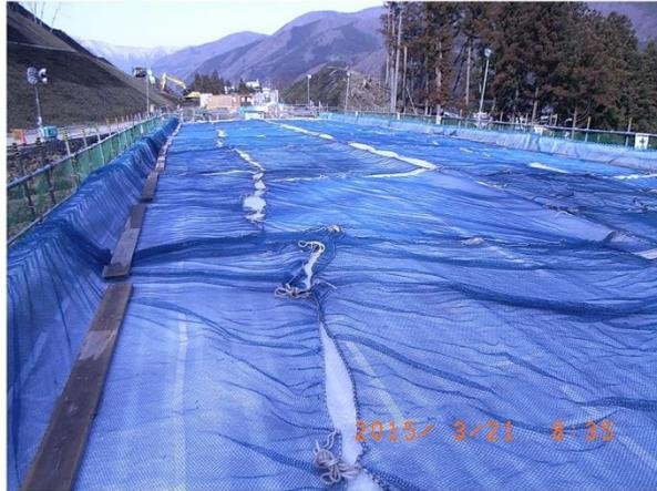
写真7-⑬ 床版上面の養生状況
