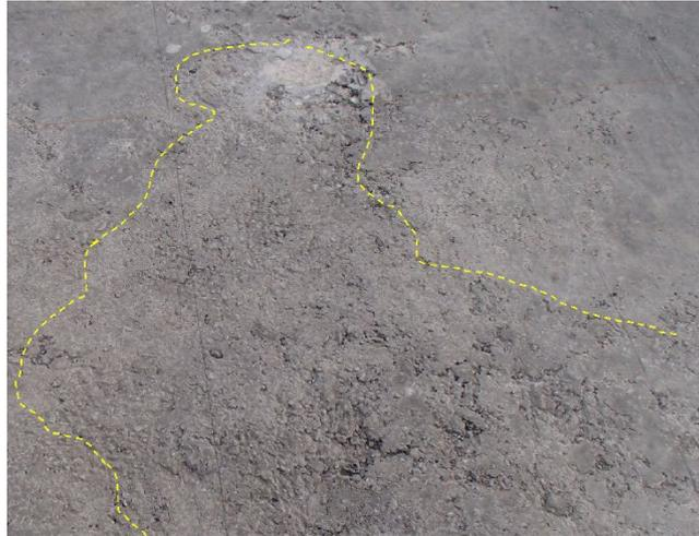
写真6-1-③ 床版上面の充填不良
