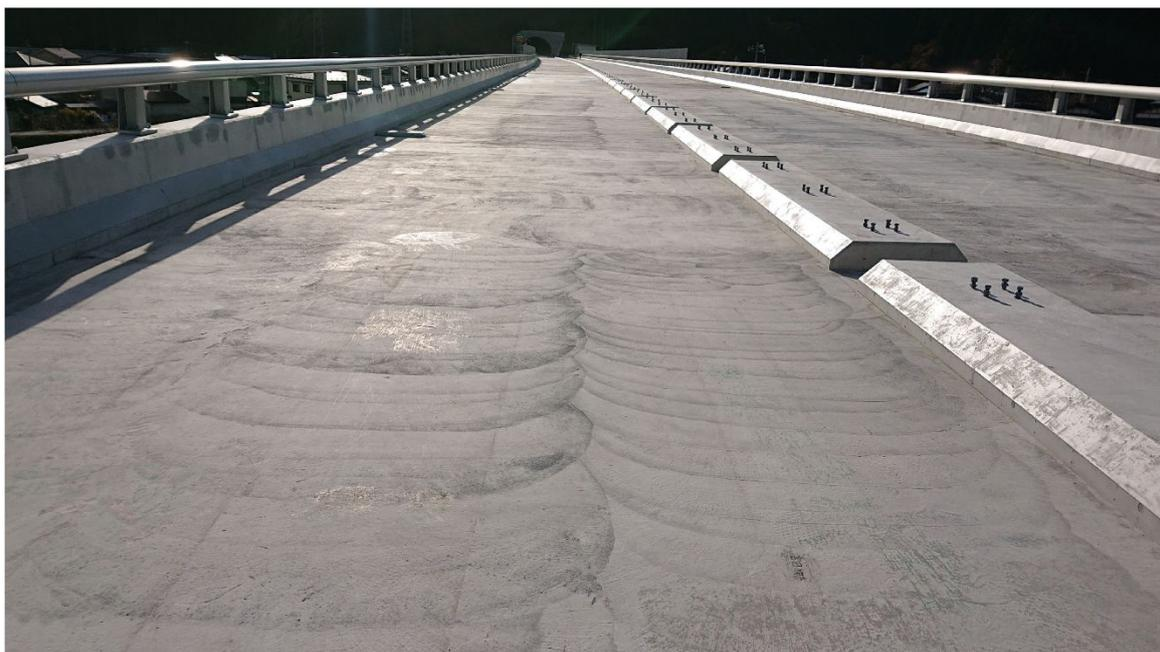
写真6-1-⑨ 床版上面に生じた仕上げ不良
