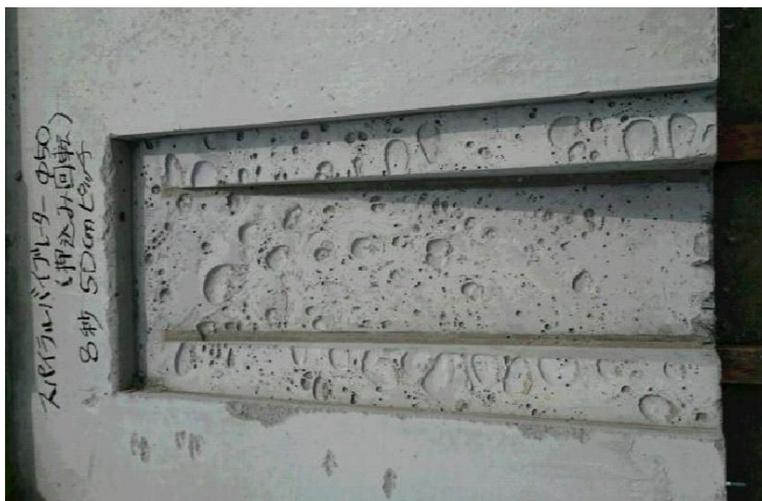
写真6-2-⑧ スパイラルバイブレードによる排水柵下の状況
