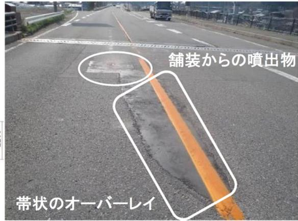
部分的に舗装のオーバーレイ(特に帯状)をしているが、舗装から噴出物がある場合は床版が土砂化している可能性が高い。
