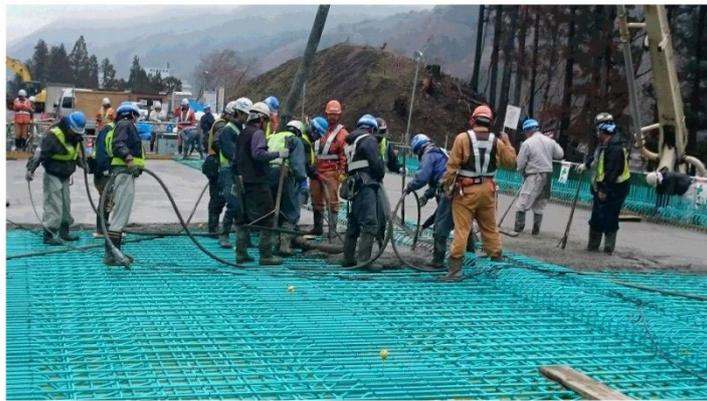
締固めと空気量の確保を両立するため締固め時間は8秒を目安打込み、締固め後、間をおかずにこて作業がついて来ている
