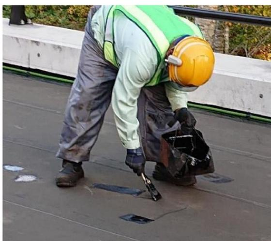
空気泡をカッターで潰して加熱アスファルトで補修
