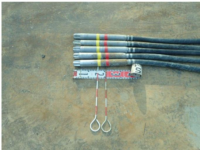
写真7-⑳ バイブレータ挿入目印のマーキング例
