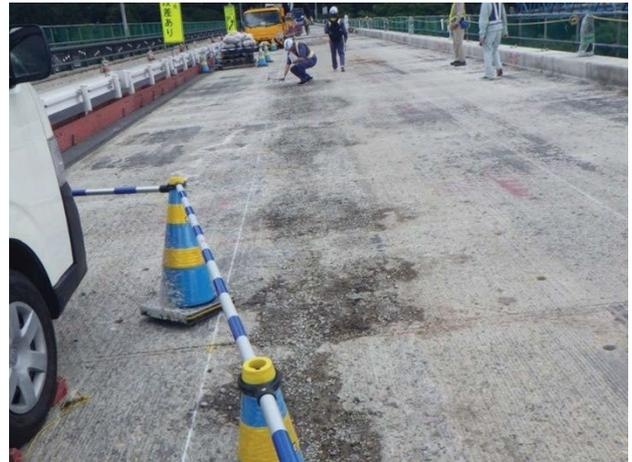
(b) 舗装目地部下の土砂化
