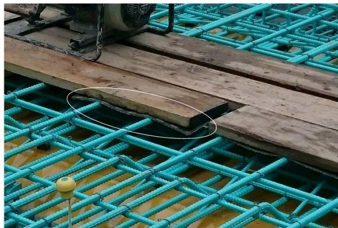
写真7-⑥ エポキシ樹脂塗装鉄筋の防護対策例①
