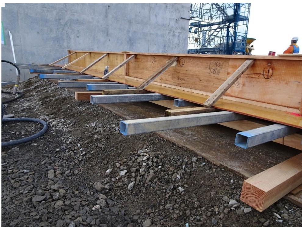
写真 6 - 2 - ⑱ 模擬床版の勾配再現架台の例
