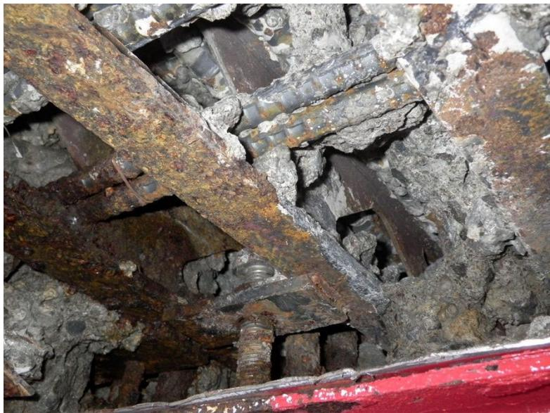
写真6-2-④ グレーチング床版コンクリートの充填不良の事例
