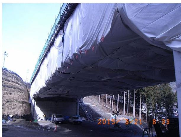
写真7-⑫ 桁下の養生状況
