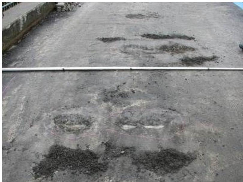
**写真 1-⑤ R C床版の土砂化の事例 (床版上面コンクリートの土砂化により凹みが発生)**
