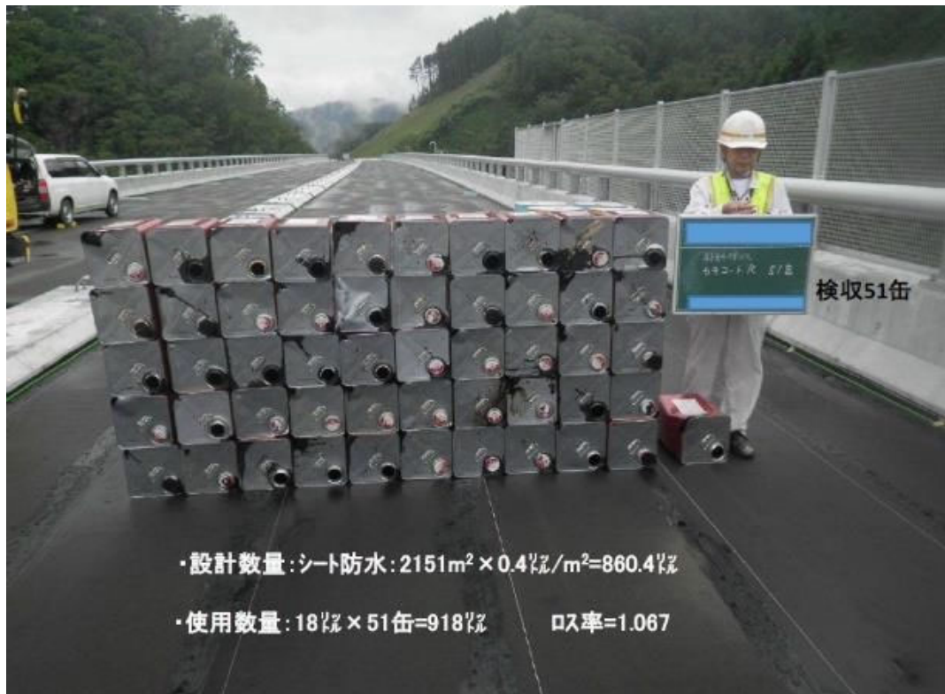
写真-1 プライマー塗布量の検収状況
