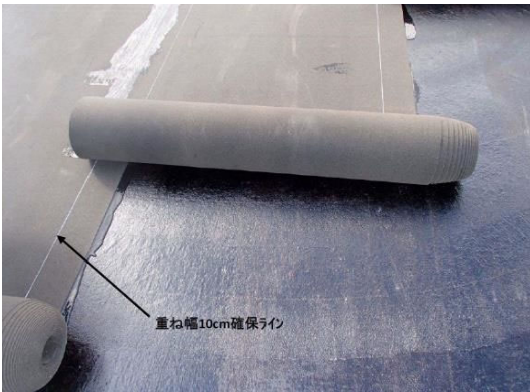
写真-1 防水シート長手方向の重ね幅 10cm 以上(流し貼り型)
