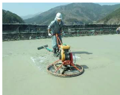
トロウエルによる仕上げ状況
