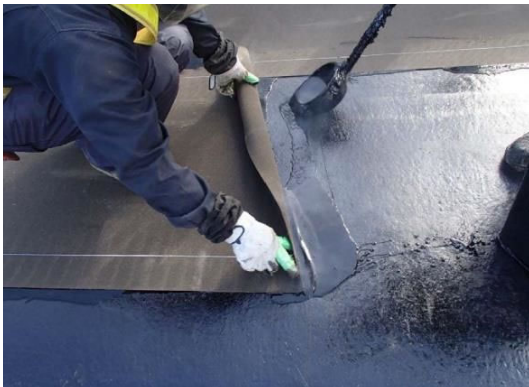
写真-2 アスファルトを柄杓で均一に流し込む(近接)
