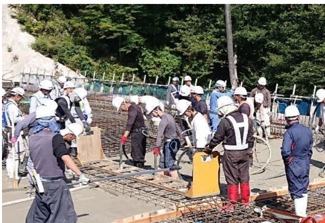
写真-10 締固めの事例
