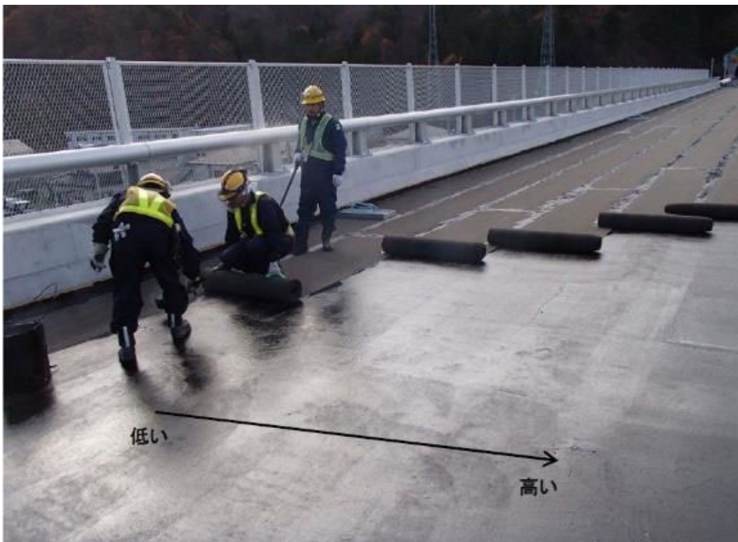
写真-1 本線橋での敷設状況(流し貼り型)
