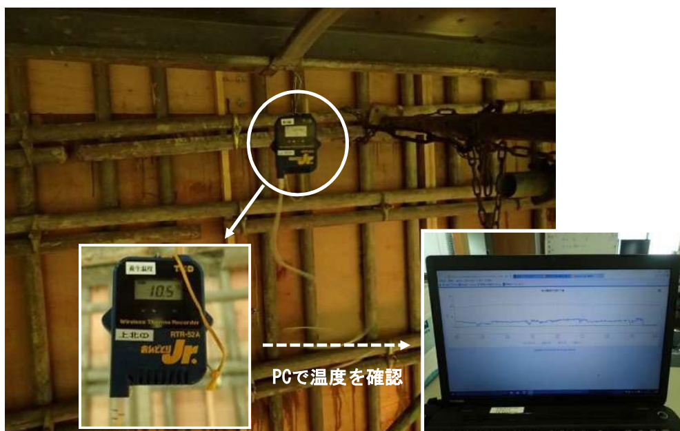
モバイル式温度計によるコンクリート温度管理
