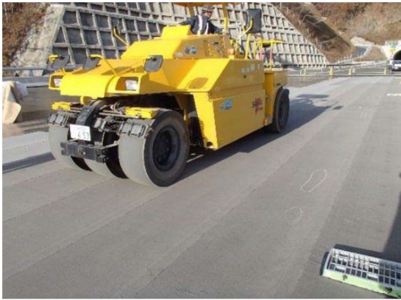
参考写真-1 シート圧着状況
