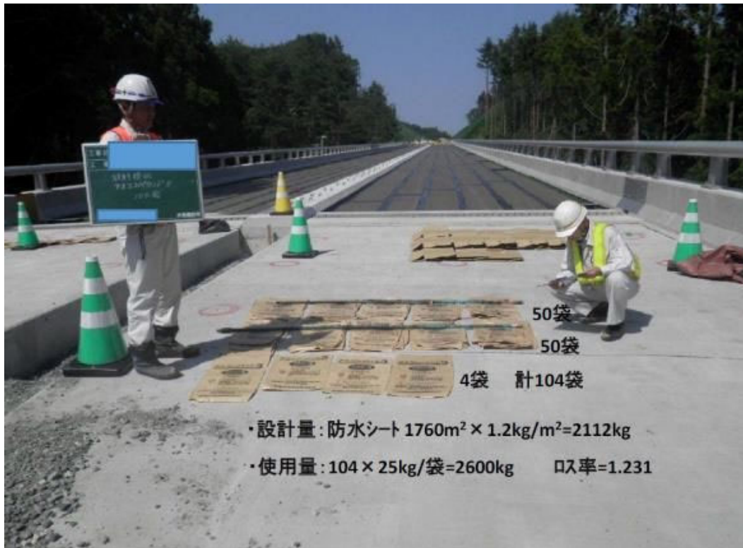
写真-1 貼り付け用アスファルト検収例(アスコンパウンド 3)
