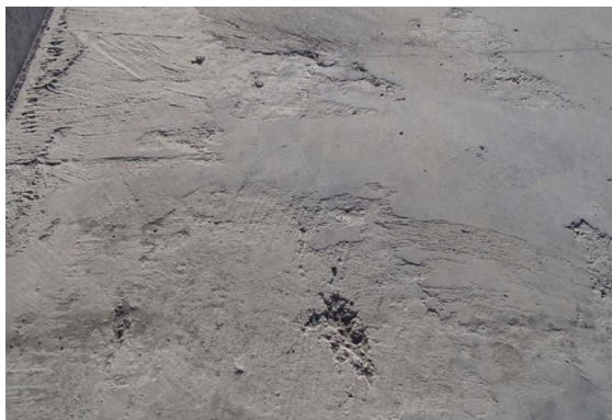
写真-2 表面に凹凸等が多い事例
