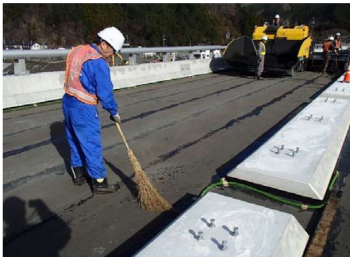
写真-2 タイヤに付着し持ち込んだ小石等の清掃 プラント～舗設場所までの合材運搬ルートに 砂利道等がある場合要注意
