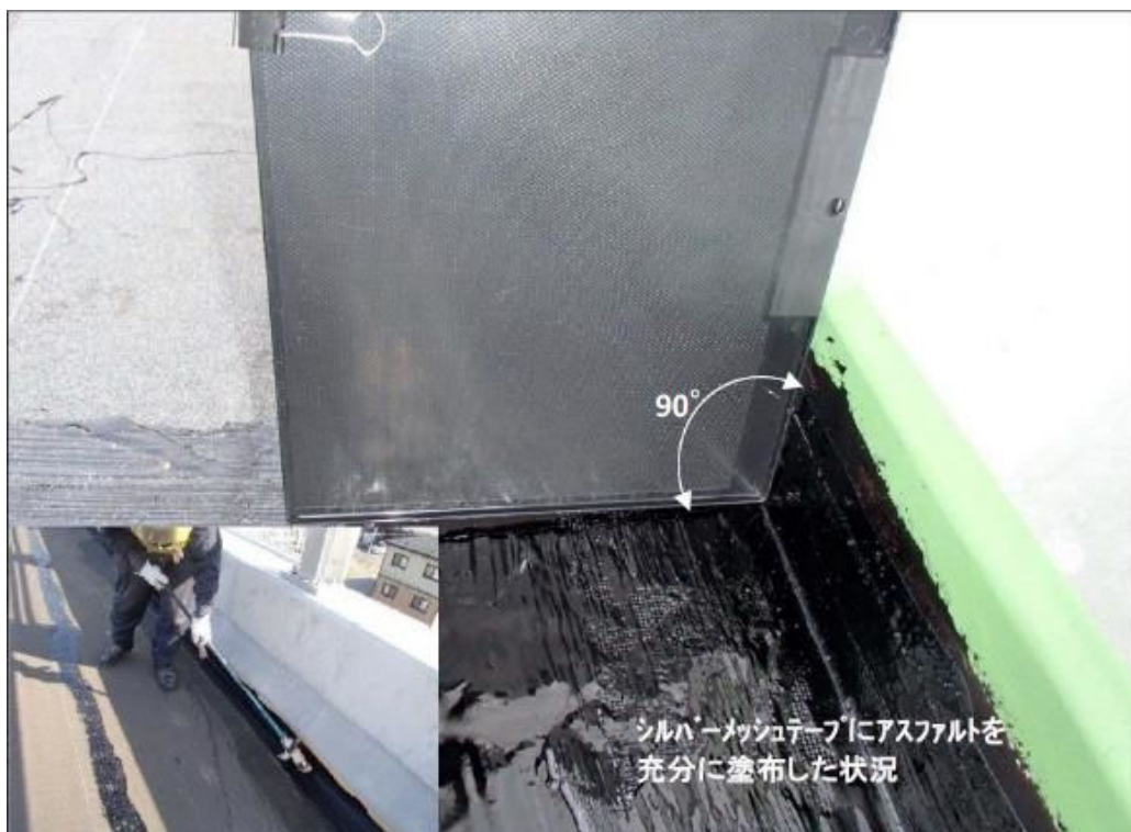
写真-3 コーナー(直角)押さえ作業の例
