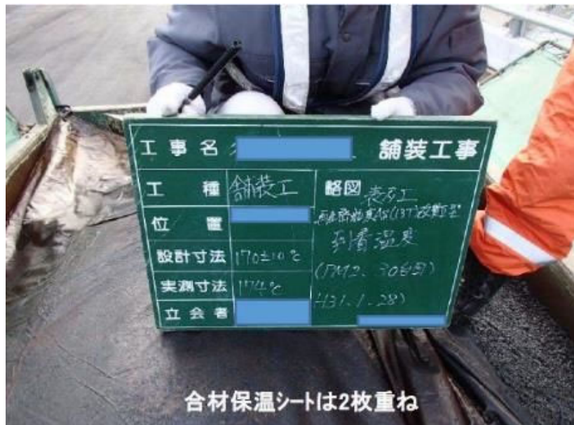
写真-1 到着時再生密粒 13T 改質 II 型※170°C±10 実測値 174°C
