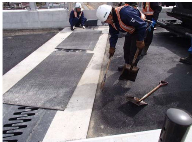
写真-2 成型目地材を撤収し清掃後、再設置する
