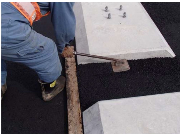
写真-2 中分開口部のコテ敷き均し状況
