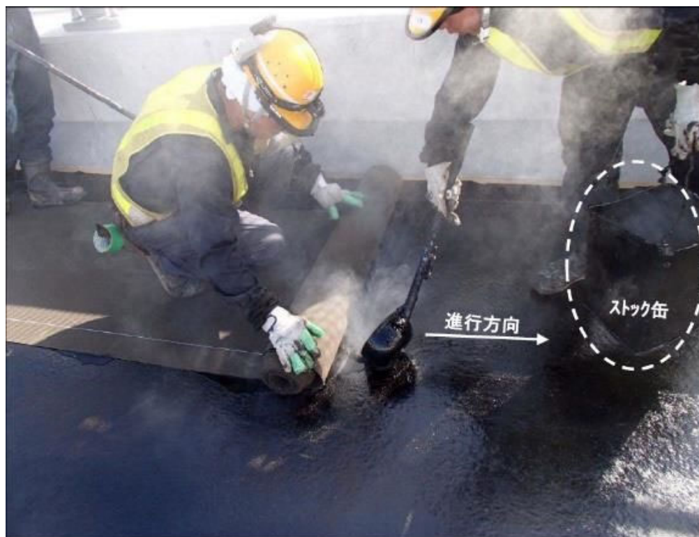
写真-2 シートの前方にストック缶:アスファルトを柄杓で投入する-
