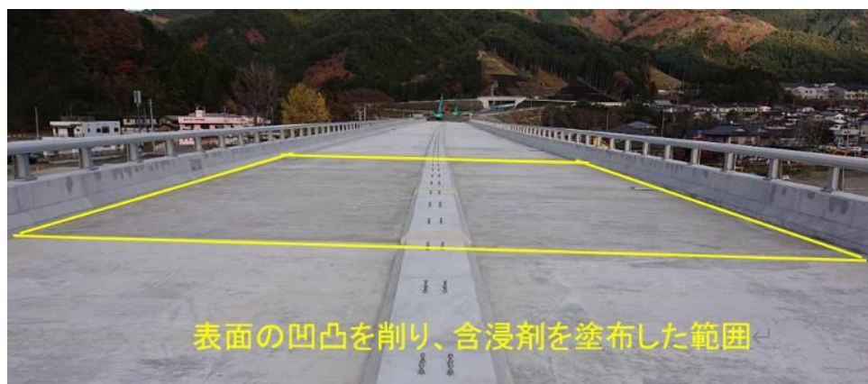
写真-6 表面の凹凸を削り、含浸剤を塗布した事例
