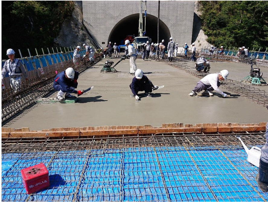
写真-14 左官工による金ゴテ仕上げの事例
