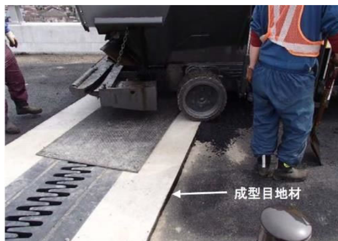
写真-3 清掃後の正しい成型目地材の設置状況。この後舗設を開始
