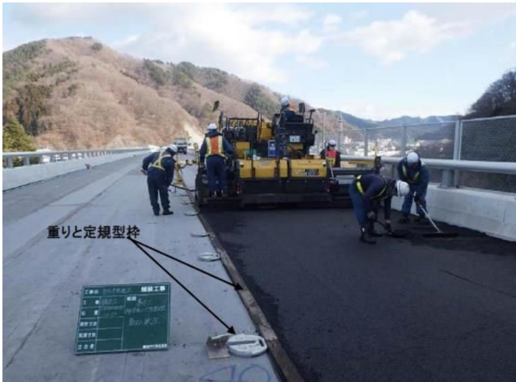
写真-1 定規型枠の継目を重りで(約 5kg)押さえている例
