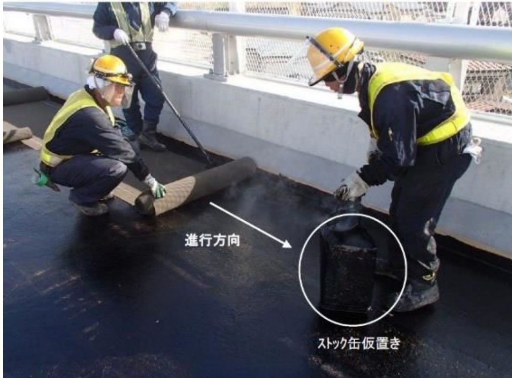
写真-1 アスファルト入れ缶を敷設防水シートの前方に仮置き
