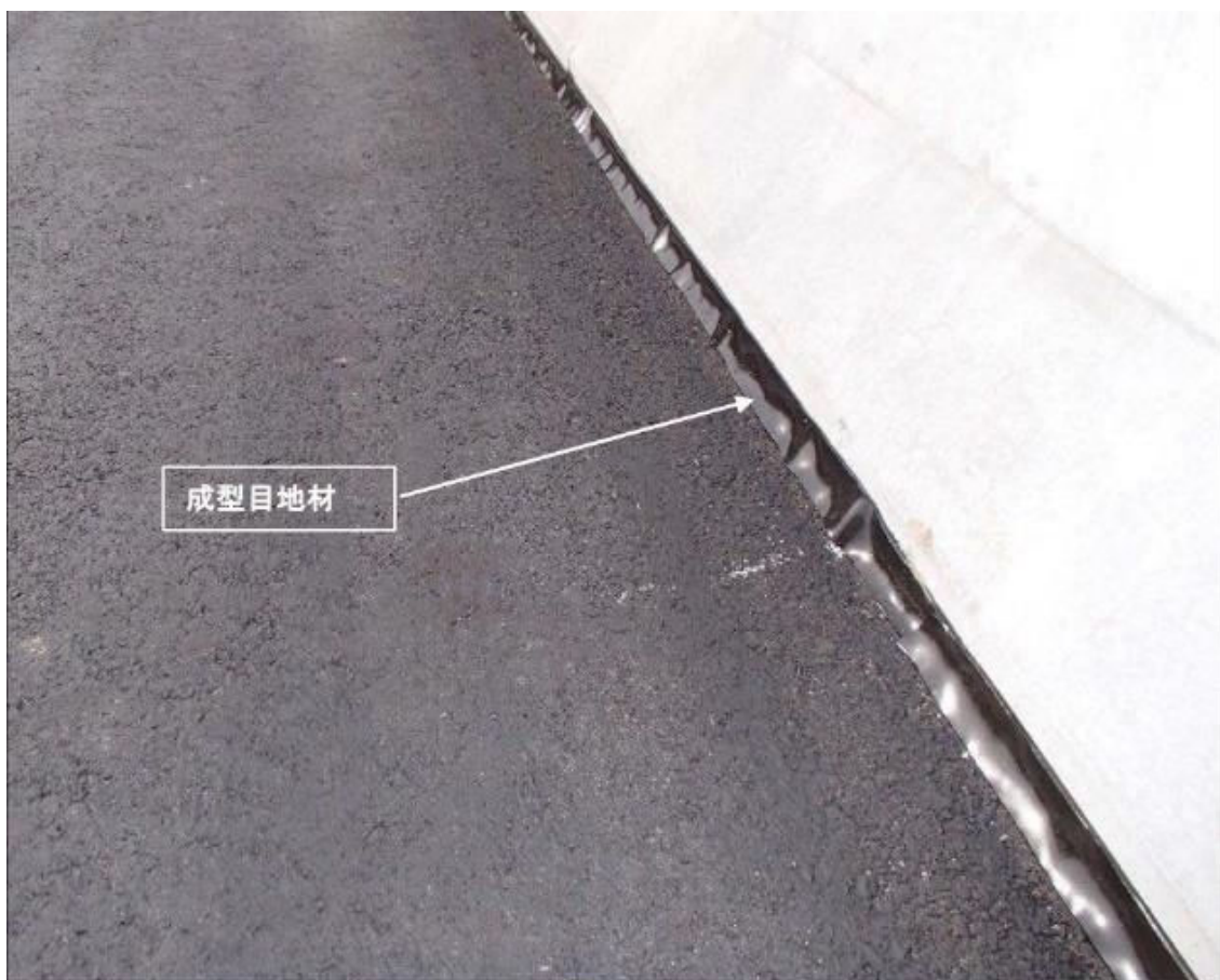
写真-3 成型目地材の設置状況(3月下旬:表層工直前) 冬期に比較し目地材が溶解気味になり付着しやすい
