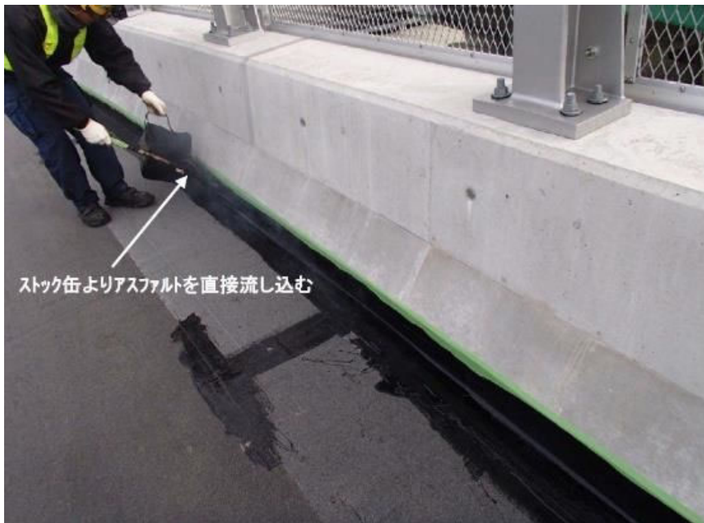
写真-1 端部処理剤にアスファルトを直接流し込んで量を確保している状況
