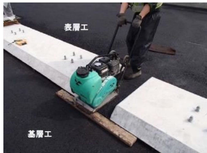
写真-2 中央分離帯側開口部の締め固め状況
