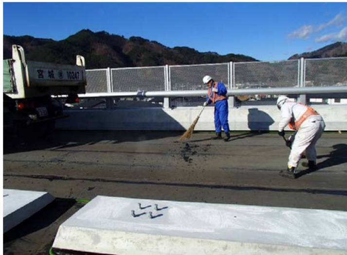
写真-1 ダンプがこぼしたAS合材の清掃状況(基層工施工中)
