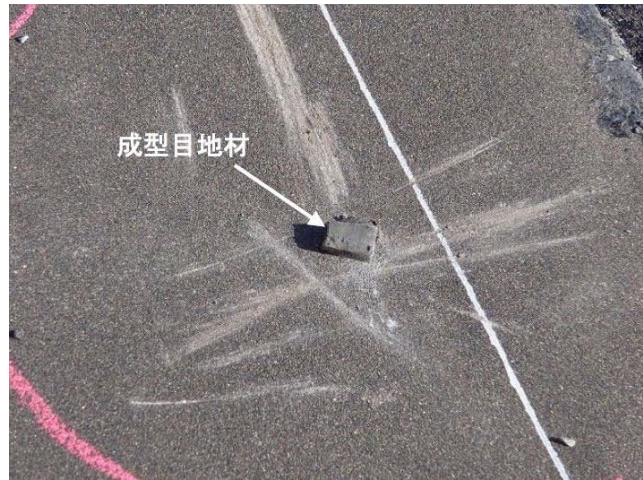
写真-1 清掃後、損傷箇所のサイズに合わせた成型目地材を設置
