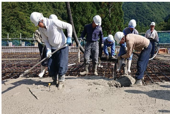
写真-9 打込みの事例
