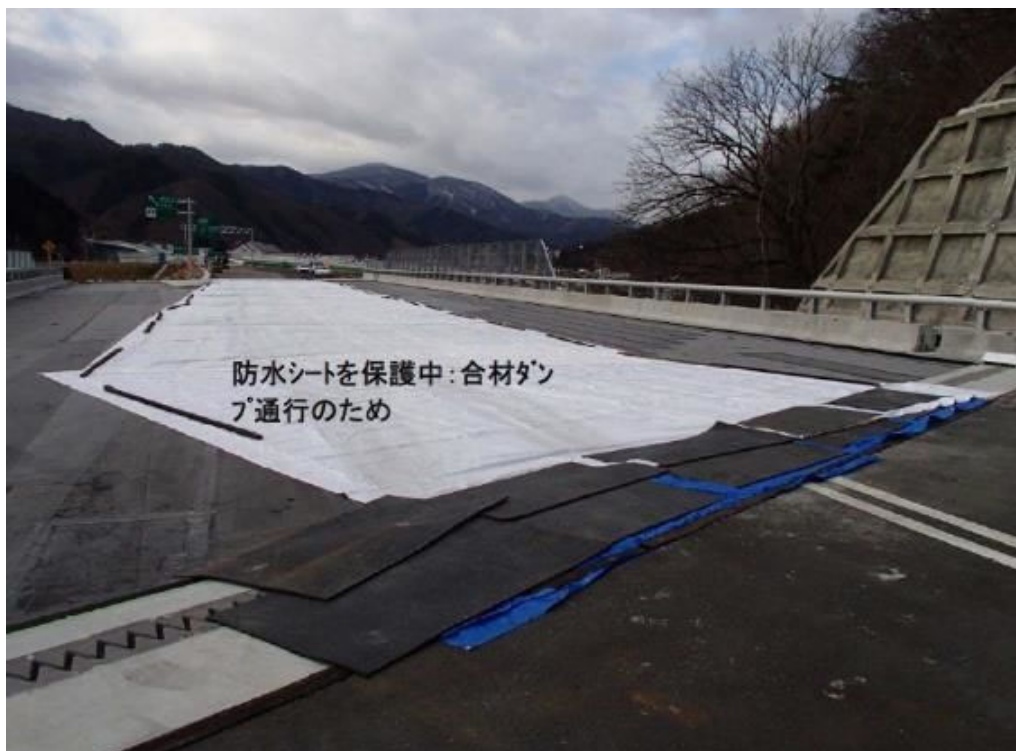
写真-2 防水シートを保護した例
