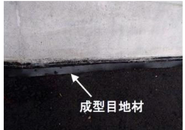
写真-2 舗設直前の成型目地材
