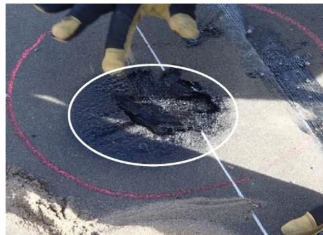
写真-3 溶解後、手先で成型目地材を均して孔を埋める 黒ずんでいる箇所：防水シートも一部分溶解される
