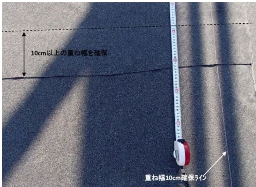
参考写真-防水シートの重ね幅ラインの明示(常温貼り型)
