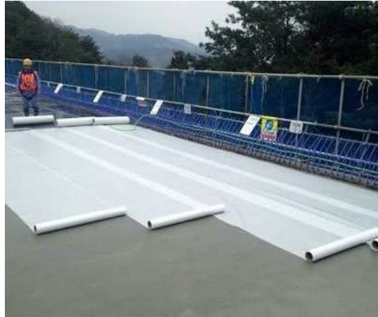
水搬送シート敷設状況
