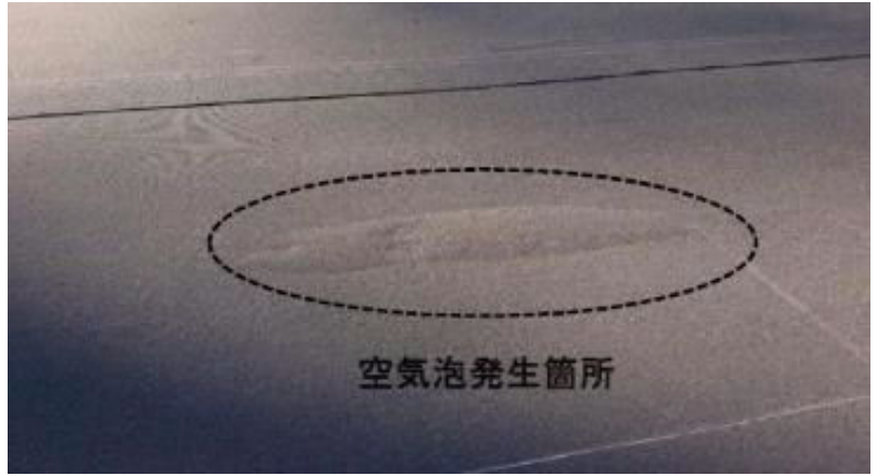
参考写真-2 シート圧着後に生じた空気泡
