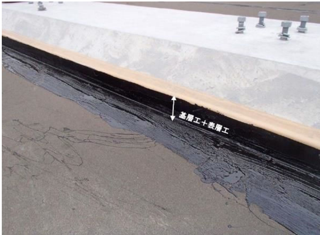
写真-1 基層工+表層工の高さまで端部にプライマーを塗布した状況
