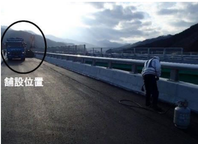
写真-3 ガスバーナーにて目地材を暖める(全景)
