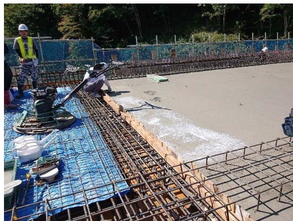
写真-12 被膜養生剤を散布している状況
