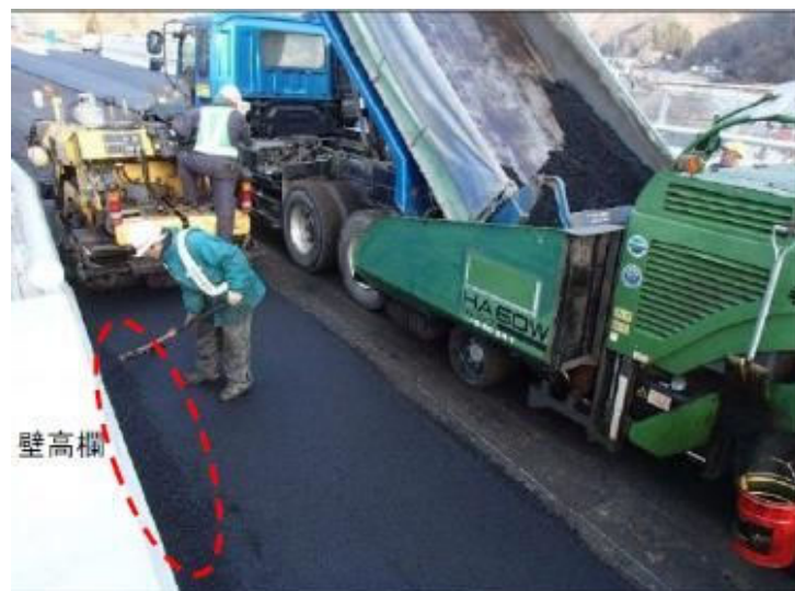
写真-3 路肩折れ端部のAsの散布による高さ調整(初期転圧後)
