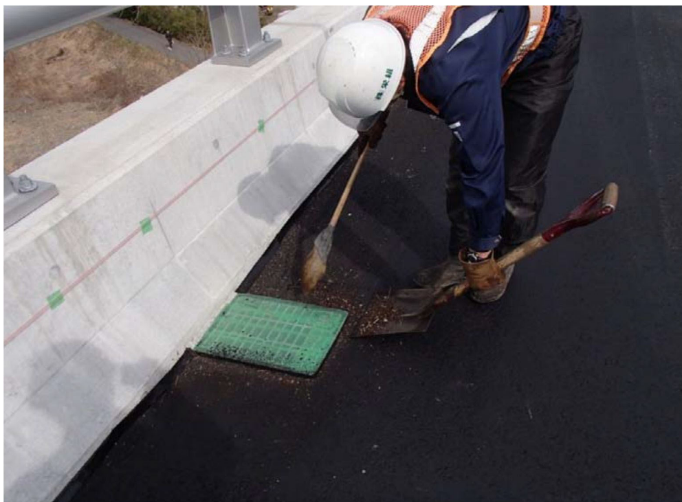
写真-2 排水柵付近に集積したゴミを表層工前に清掃
