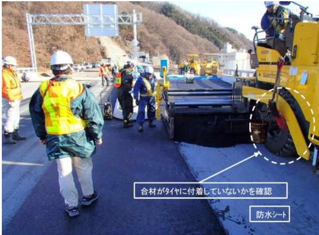
写真-1 基層工の施工状況
