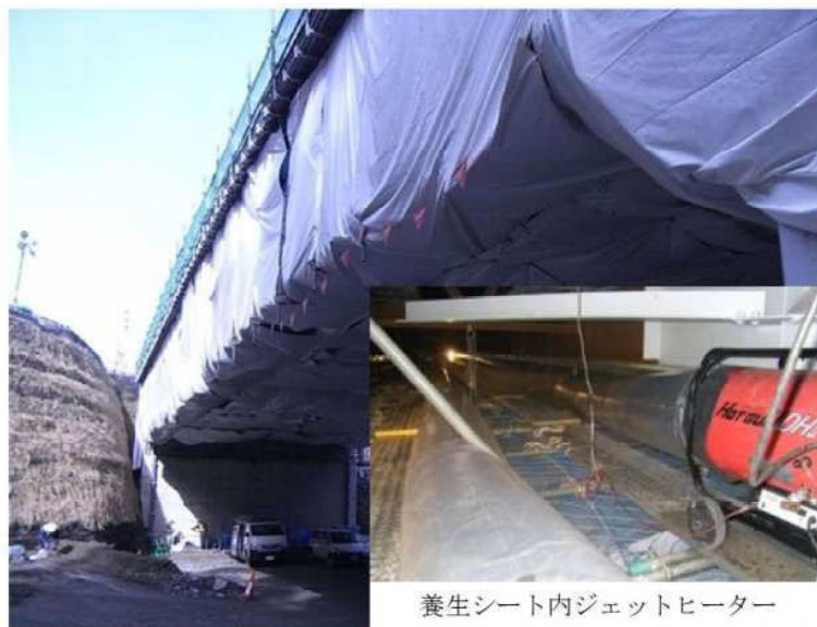
写真-1 床版下面の養生状況写真
