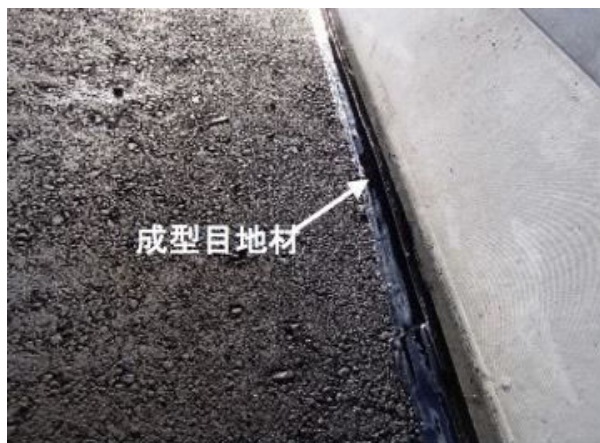
写真-5 成型目地材が少し溶解されたところで舗設する
