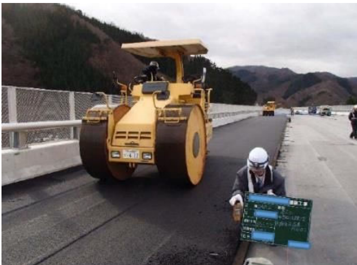
写真-2 初期転圧時再生密粒 13T 改質Ⅱ型※155°C±10 実測値 164°C
