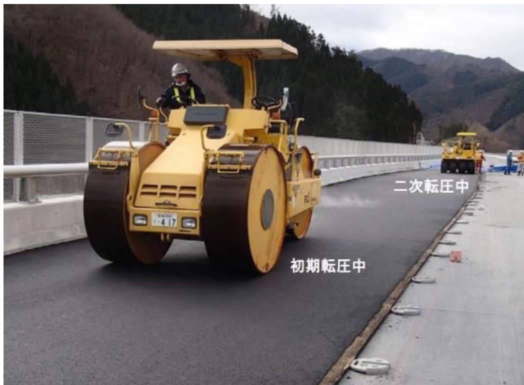
写真-2 タイヤローラ、マカダムローラにて転圧作業(定規型枠の動きはなし)
