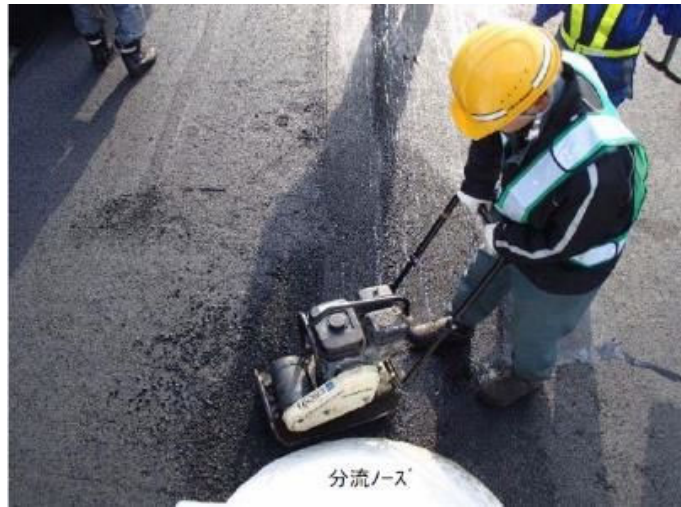
写真-1 分流ノズ付近をプレートによる締め固め状況
