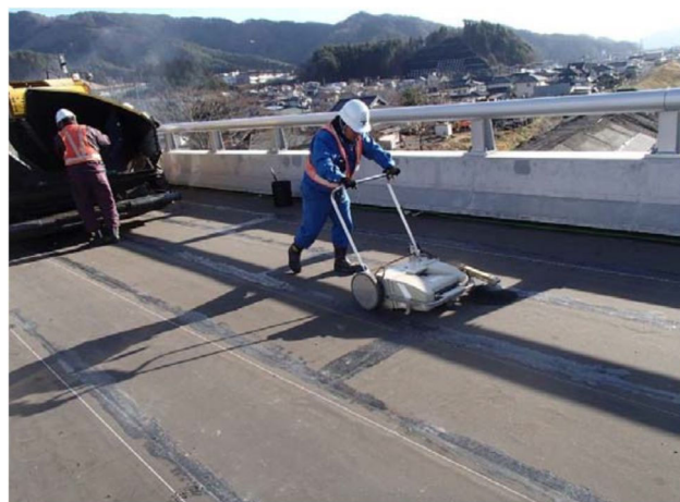
写真-4 簡易清掃機による清掃状況
