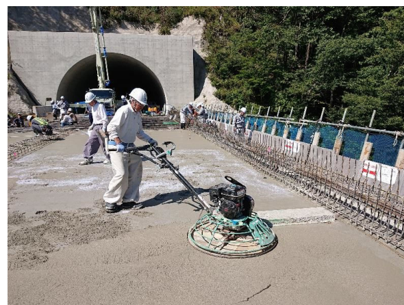
写真-13 仕上げ機械(円盤式)での仕上げ作業
