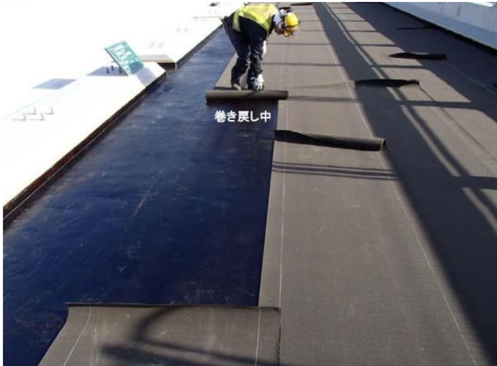
写真-1 施工線に沿っての試し貼り状況(風のない日を選定)-
