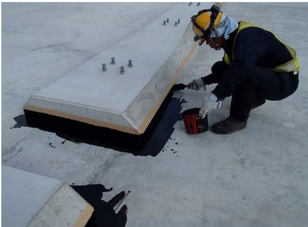
写真-2 刷毛による塗布状況(中央分離帯側) この時に薄塗りにならないように施工する
