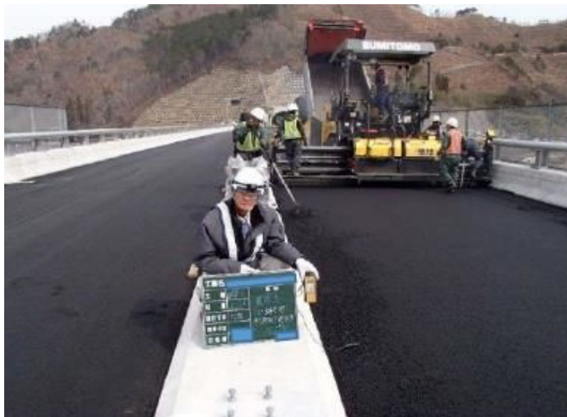
写真-2 初期転圧時再生密粒 13T 改質 II 型※155°C±10 実測値 161°C
