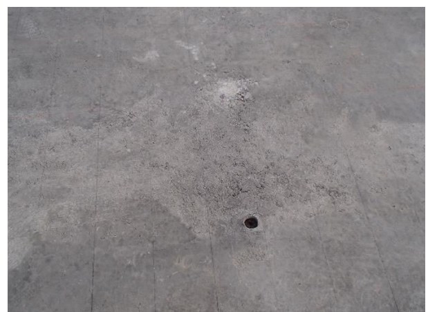
写真-5 足場下の仕上げ状況 (写真中の穴は単管の除去跡)
