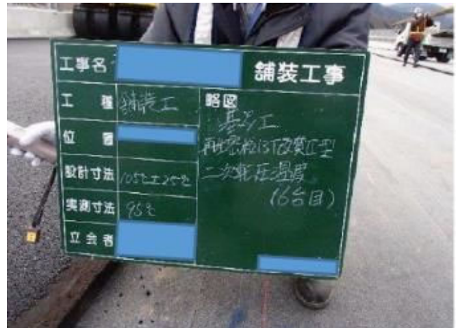
写真-3 二次転圧時再生密粒 13T 改質Ⅱ型※105°C±25 実測値 95°C
