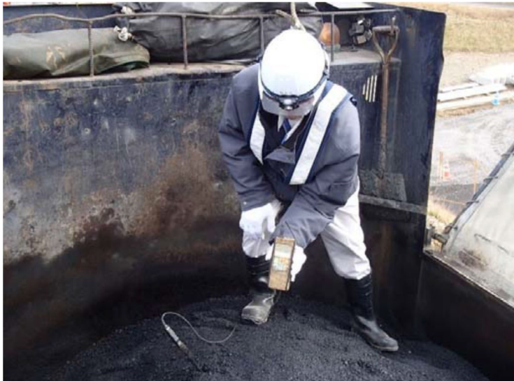
写真-1 到着時再生密粒 13T 改質Ⅱ型※170°C±10 実測値 169°C
