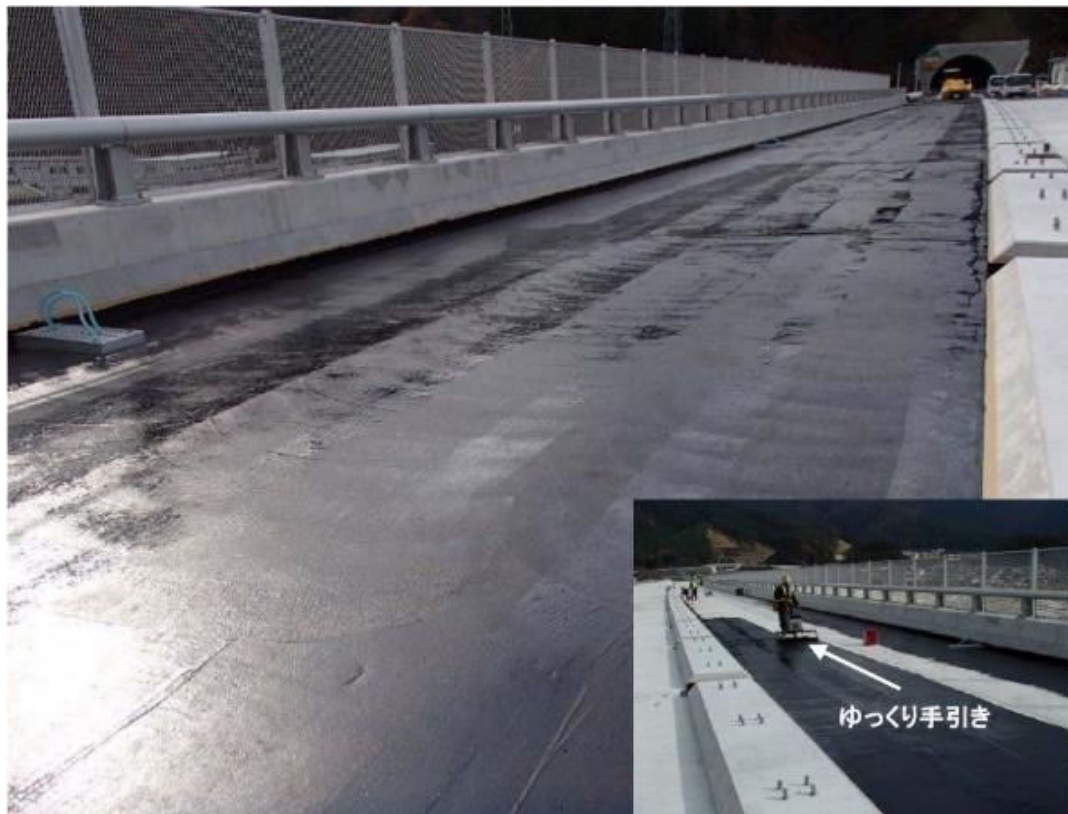
写真-2 プライマー塗布完了状況(均一でムラがない状態)
