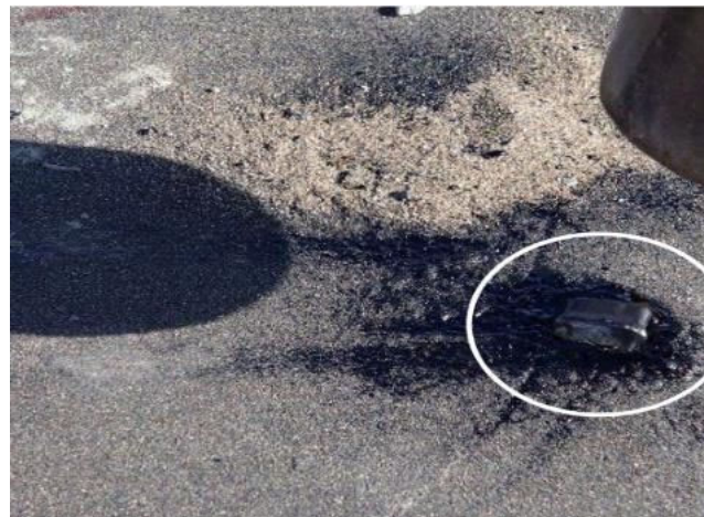
写真-2 ガスバーナーにて成型目地材を暖め溶解させる
