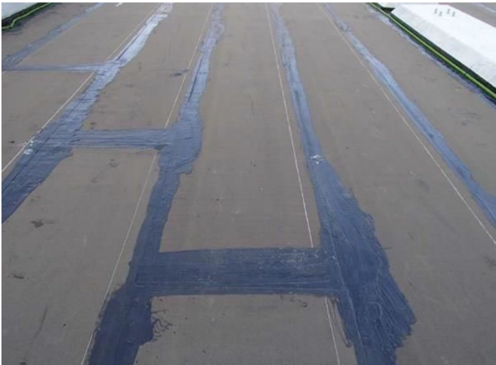
写真-1 防水シート貼り付け(平滑仕上げ)状況
