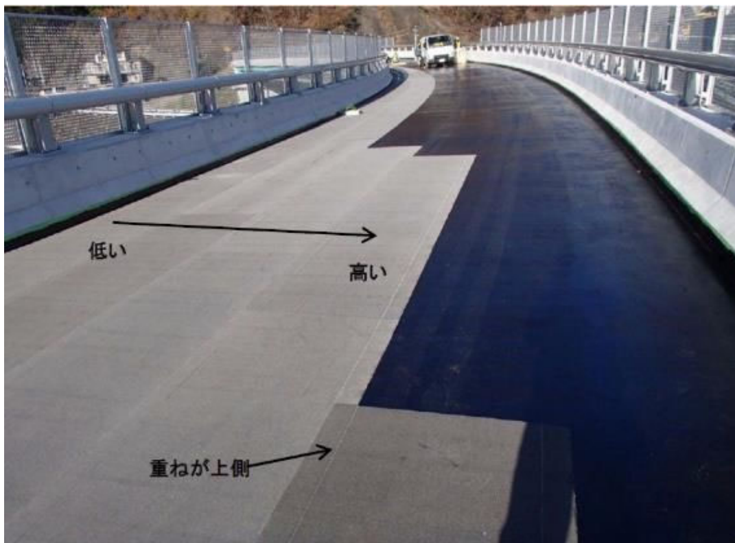
参考写真-ランプ橋での敷設状況(常温貼り型)
