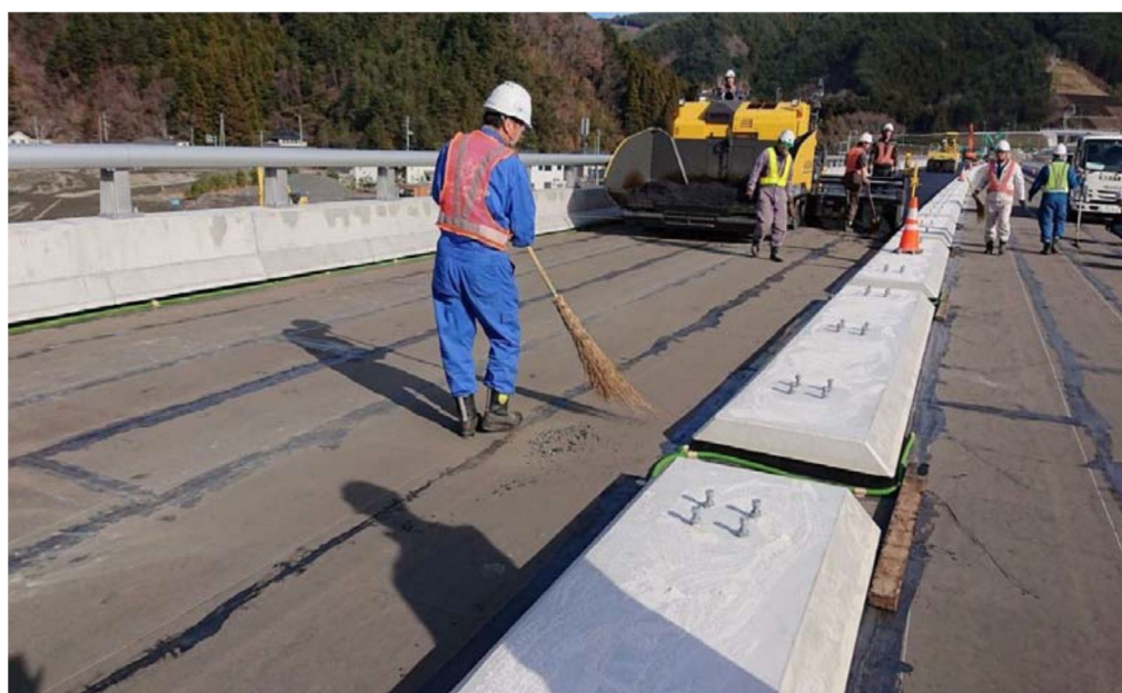
写真-2 防水シート上を舗設中に清掃する事で小石等で防水シートが損傷する事を予防できる
