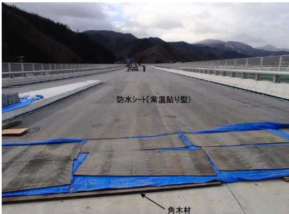
写真-1 基層工(表層工)施工時の伸縮装置の保護例 (端部段差に角木材、伸縮装置全体にブルーシート+ゴムマット設置)
