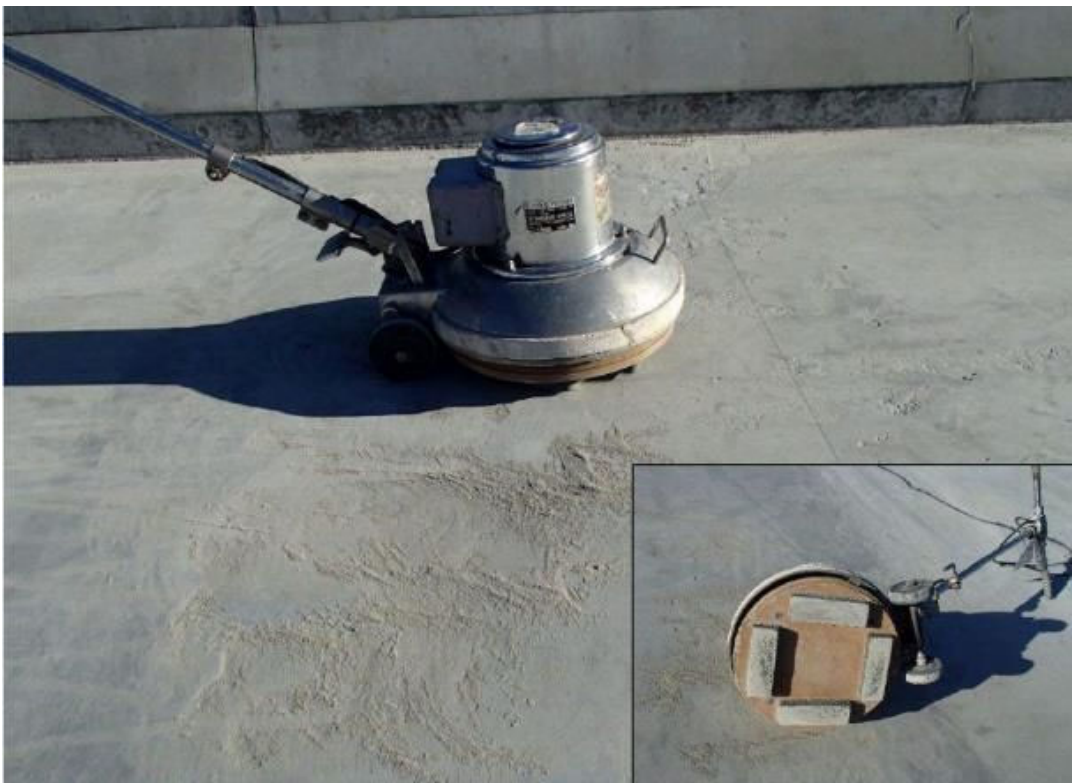
写真-2 サンドー(砥石型)によるレイタンス除去例
