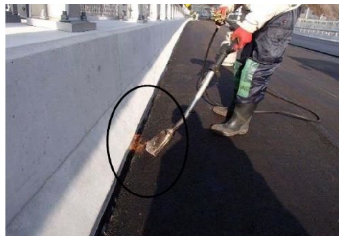
写真-4 ガスバーナーで暖め状況(近接)
