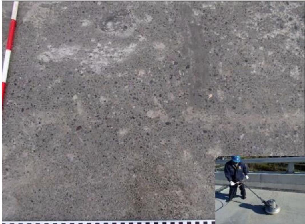
写真-1 サンダーによる被膜養生剤を除去した例:緻密性が失われその後、含浸剤を防水工との接着を阻害しないために塗布する
