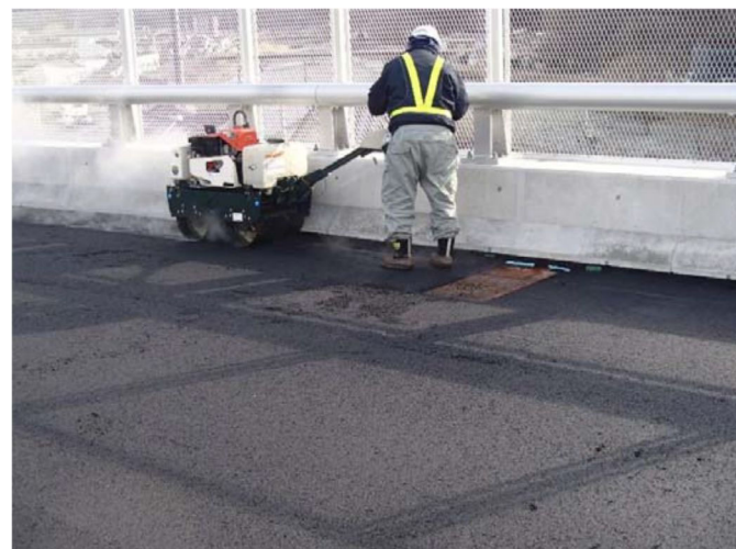
写真-3 路肩折れ端部の転圧状況(小型振動ローラーによる)
