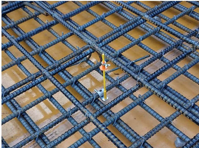
写真-7 高さ表示棒を下側鉄筋に定着した事例
