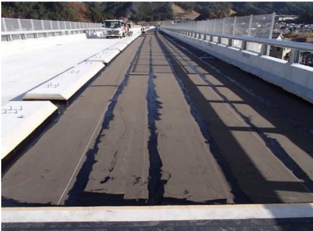
写真-2 はみ出したアスファルトの均し完了状況
