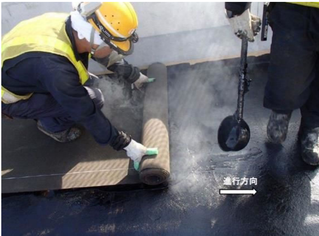
写真-1 ロール重さを利用した敷設例
