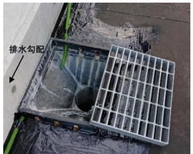
写真-3 排水柵への設置状況
