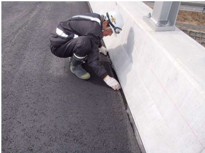
写真-1 成型目地材設置状況(地覆側)
