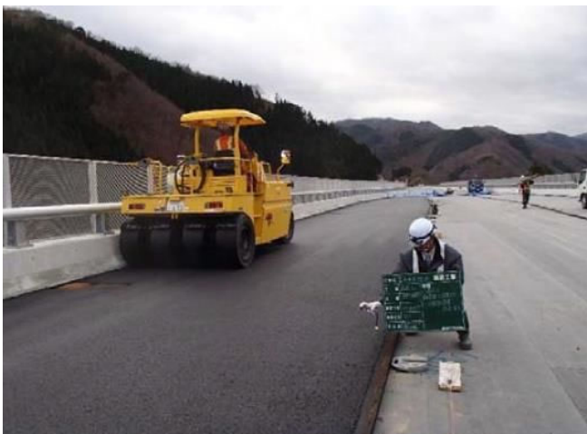
写真-3 二次転圧時再生密粒 13T 改質Ⅱ型※105°C±25 実測値 95°C
