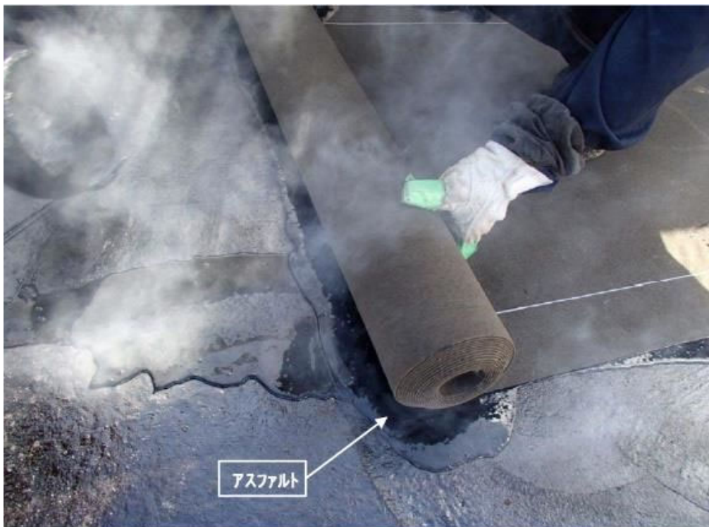
写真-2 アスファルトをロール重さを利用して押し出すイメージ
