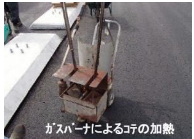
写真-2 中分開口部のコテ敷き均し状況
