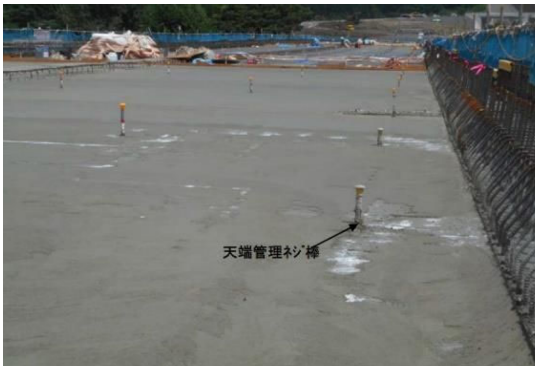
参考写真-天端仕上げ高さの管理ネジ棒の撤去タイミングが遅く、機械式仕上げのトrowエルが十分に使えず、部分的に被膜養生剤が残った例
