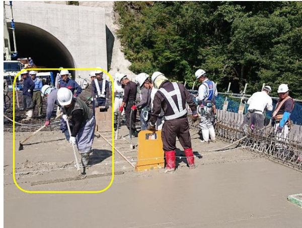
写真-11 左官工による荒仕上げの事例
