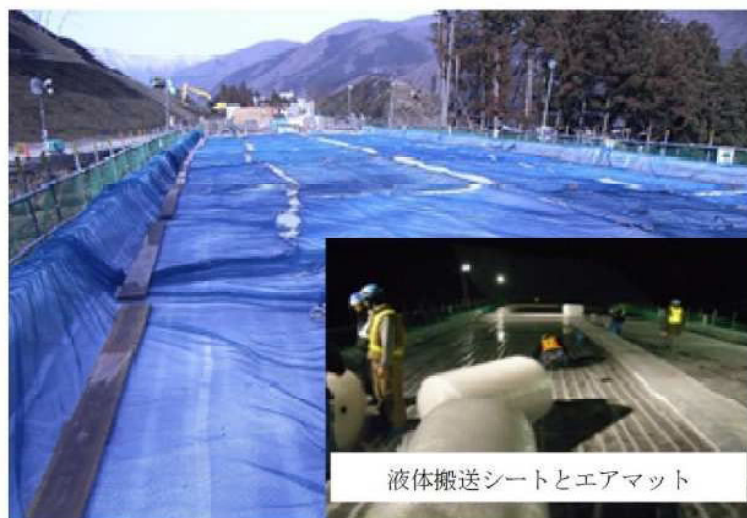
写真-2 床版上面の養生状況写真
