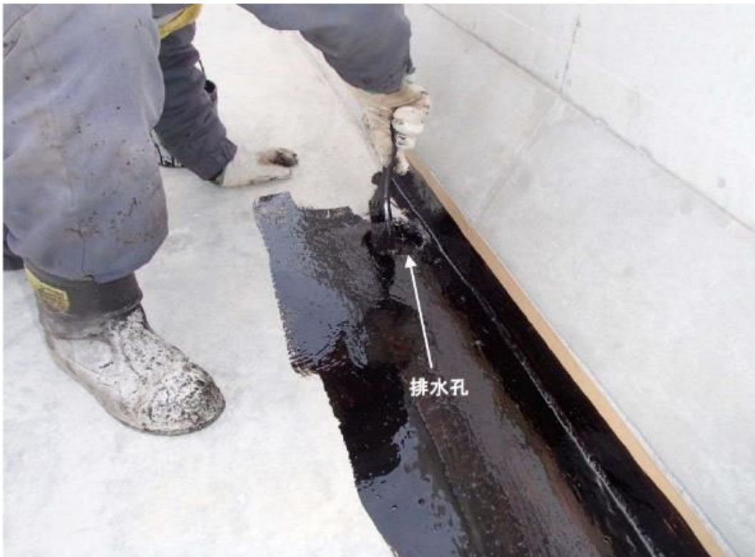
写真-1 地覆、排水孔周りを刷毛による塗布状況
