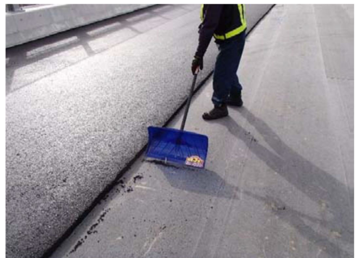
写真-3 基層定規型枠を撤去後のAS清掃
