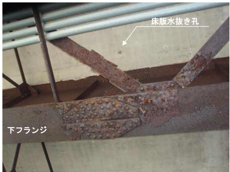
写真2. 4. 8 床版水抜き孔の影響により層状錆が発生した耐候性鋼材を使用した橋梁の添接部
