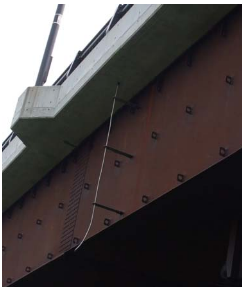
写真2. 4. 5 導水管の支持状況
