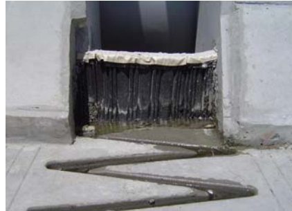
(例) 地覆部直角立ち上げ写真
