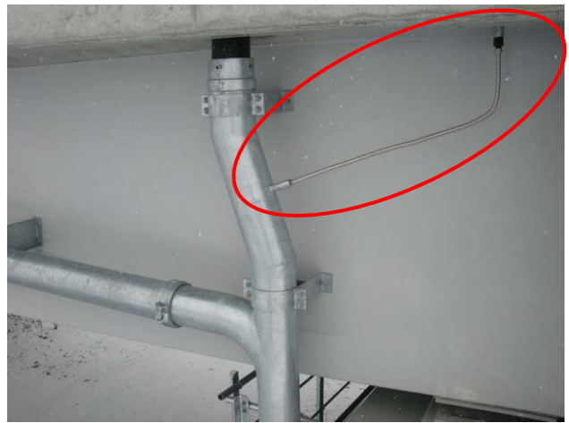
写真2. 4. 7 設計時に横引き排水管への導水を計画したPC橋の事例
