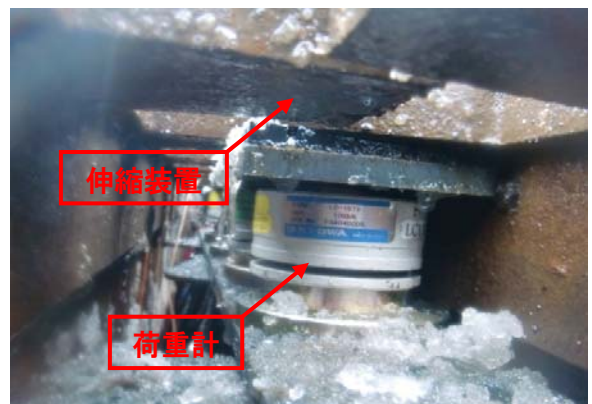
写真2. 1. 1 荷重計の設置状況
