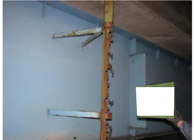
写真2. 7. 1 排水管の腐食状況
