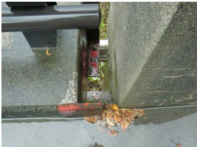
写真2. 1. 9 地覆、壁高欄部立ち上がり部の好ましくない事例 (地覆、壁高欄立ち上がり部に隙間があり、水密性を有していない事例)
