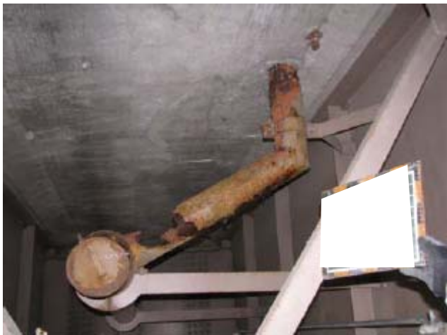
写真2. 7. 1 排水管の腐食状況
