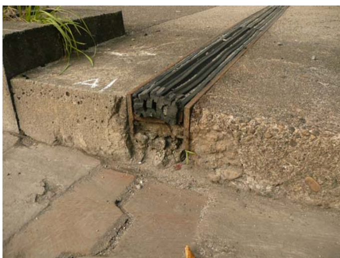
写真2. 1. 10 歩車立ち上がり部の好ましくない事例 (歩道立ち上がり部に隙間があり、水密性を有していない事例)
