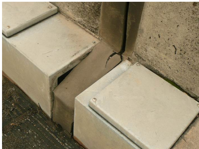
写真2. 1. 9 地覆、壁高欄部立ち上がり部の好ましくない事例 (地覆、壁高欄立ち上がり部に隙間があり、水密性を有していない事例)
