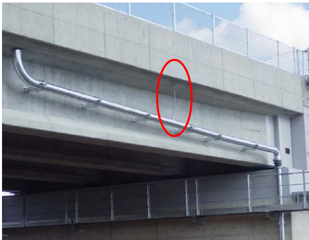
写真2. 4. 7 設計時に横引き排水管への導水を計画したPC橋の事例
