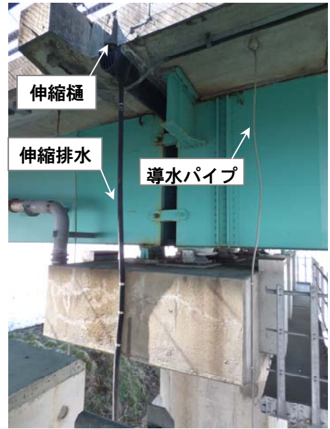
写真2. 4. 4 垂直に導水し滞水や土砂詰まりが生じにくい事例
