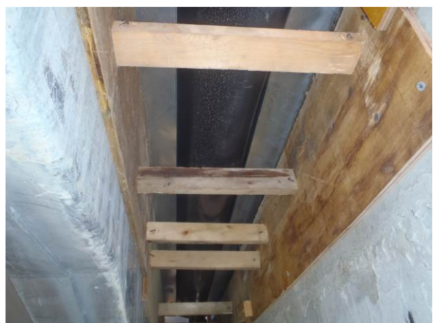
写真2. 1. 8 木製型枠による施工事例（型枠取り外し前）
