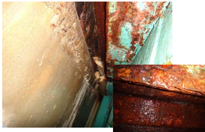
写真 2. 1. 13 埋設ジョイントを採用した鋼橋の桁端部の著しい腐食
