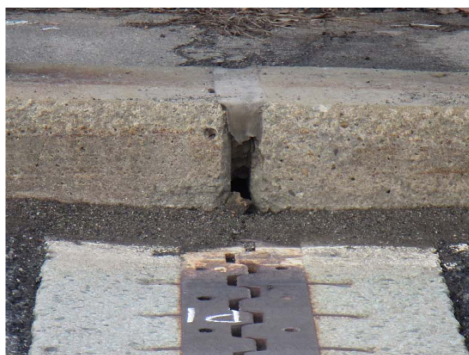
写真2. 1. 10 歩車立ち上がり部の好ましくない事例 (歩道立ち上がり部に隙間があり、水密性を有していない事例)
