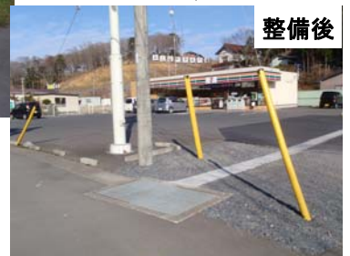
側溝と舗装の施工により転落危険を解消
