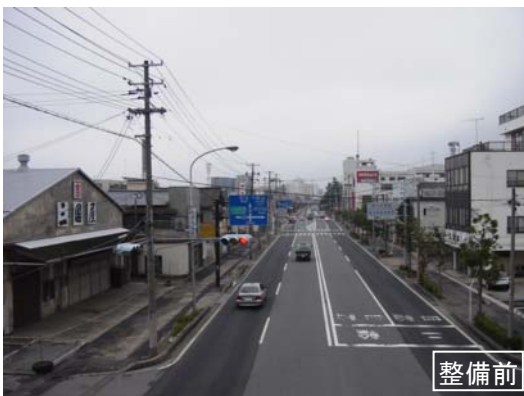
【福島県いわき市平字五色町(国道6号)】
