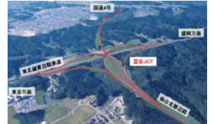
(仮)大衡インターチェンジ整備
