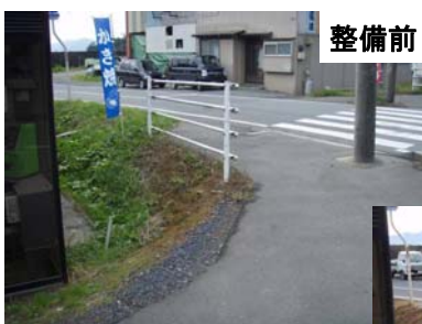
歩道が狭く、歩行者が留まらない。
