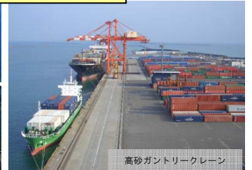
高砂ガントリークレーン
