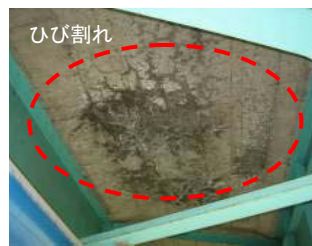
損傷状況(床版の疲労)
