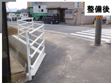
土留め擁壁と転落防止柵の施工で歩道幅を拡げた。
