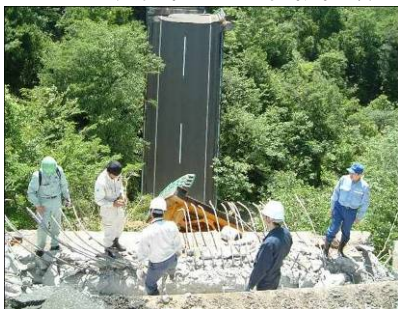
図 21 岩手・宮城内陸地震(H20.6)における被害状況(祭時大橋)
