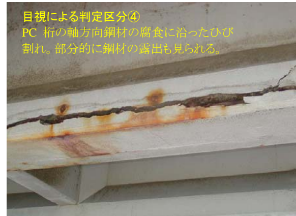
写 5.1 耐荷性能の低下が懸念される橋梁の外観損傷状況の例
