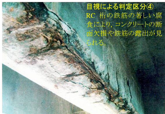
写 5.1 耐荷性能の低下が懸念される橋梁の外観損傷状況の例
