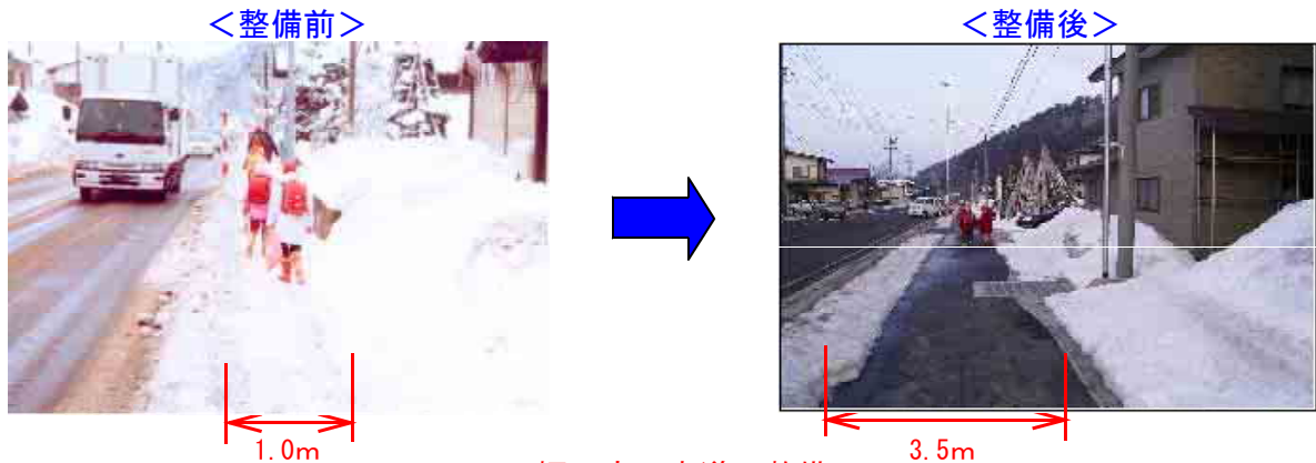
<幅の広い歩道の整備>
