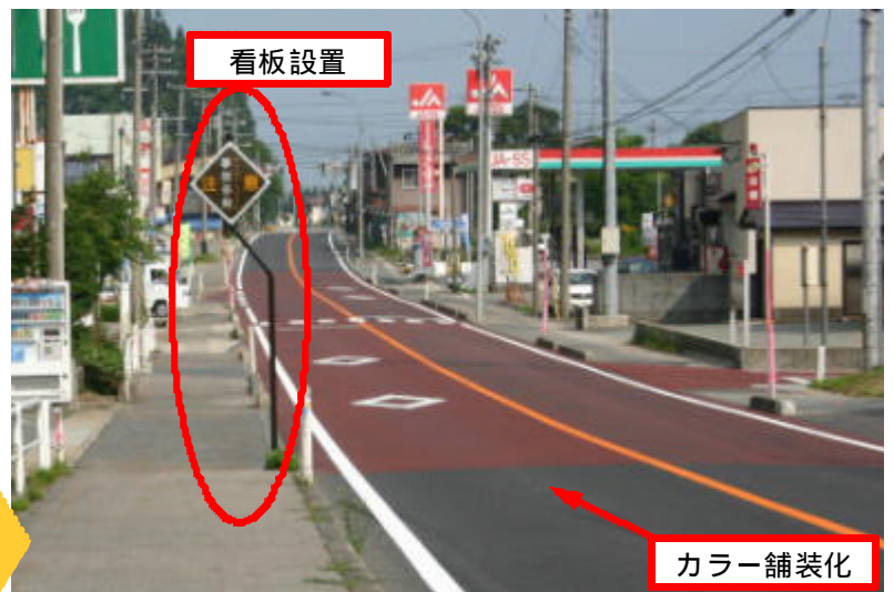
対策後の状況（鶴岡 寒河江方面）
