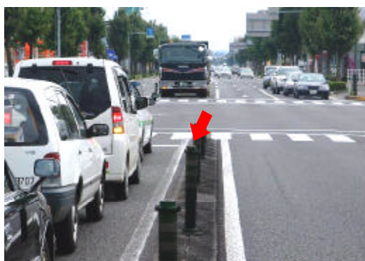
自発光式デリネーターの設置
