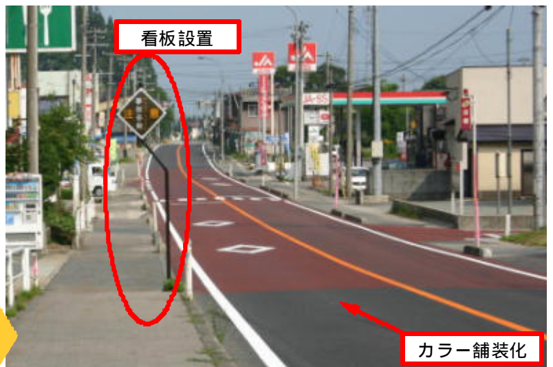
対策後の状況（鶴岡 寒河江方面）
