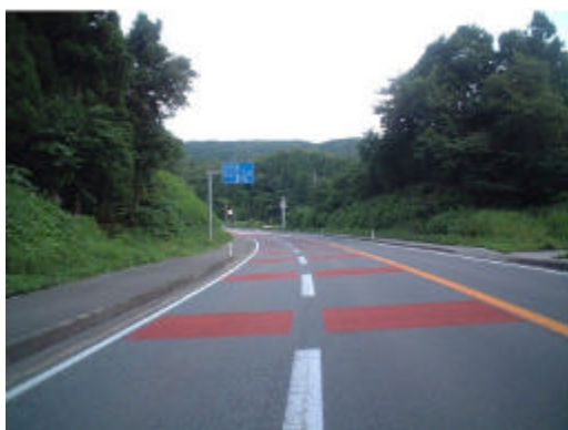
滑り止め・速度抑制舗装
