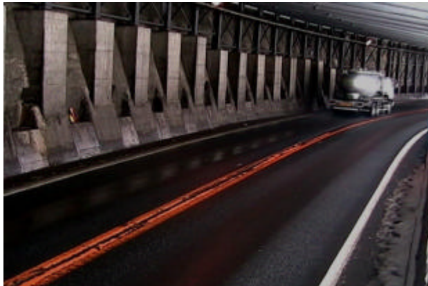
< 設置前の状況 >
