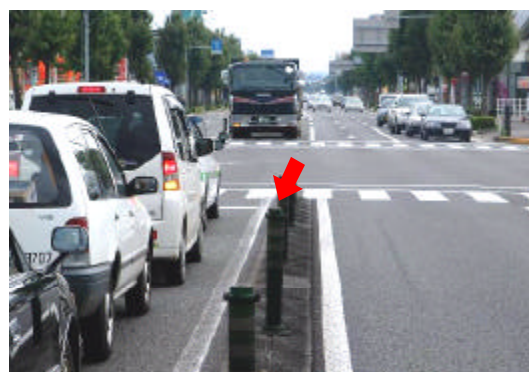
自発光式デリネーターの設置
