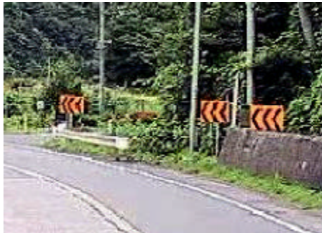
大型視線誘導標
