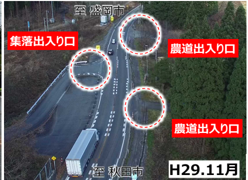
【写真3】沿道出入り箇所の状況
