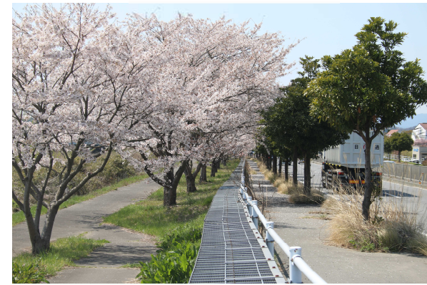
【写真1】桜堤の状況
