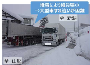
▼道路幅員の状況
