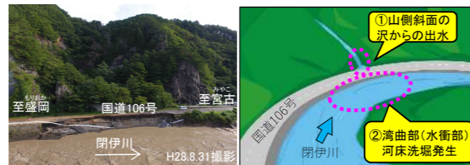
図4 河川並行区間の被災状況(他区間)と模式図
