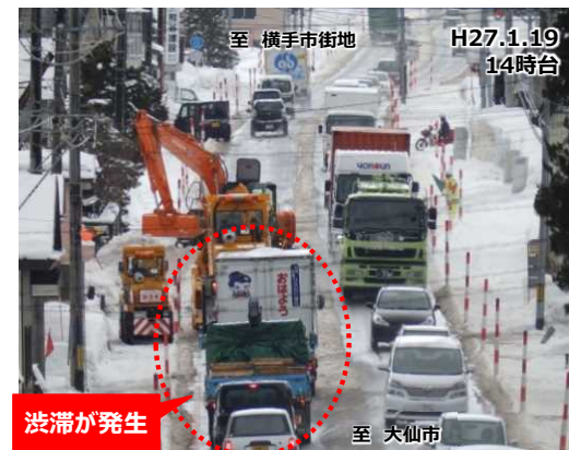
【写真1】運搬排雪作業状況
