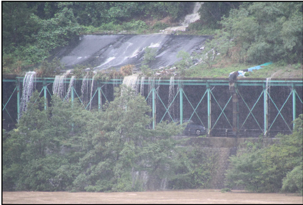
【写真2】大雨によるスノーシェッド上方法面からの出水状況(H30.8.31)
