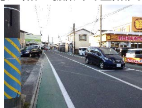
【写真①】丸井戸～孤継交差点の国道108号の道路状況
