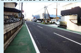
国道108号現道部のカラー舗装（歩行者通行帯の確保）
