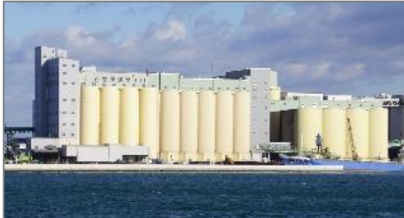
■石巻港の飼料製造工場
