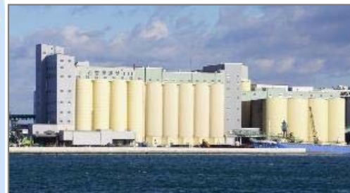
■石巻港の飼料製造工場
