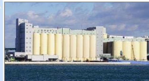
■石巻港の飼料製造工場
