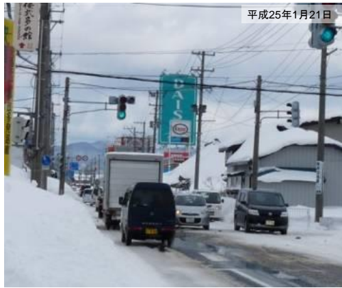
▲幅員狭小箇所【①】
