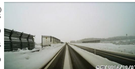
▼道路状況(五所川原東IC付近)
