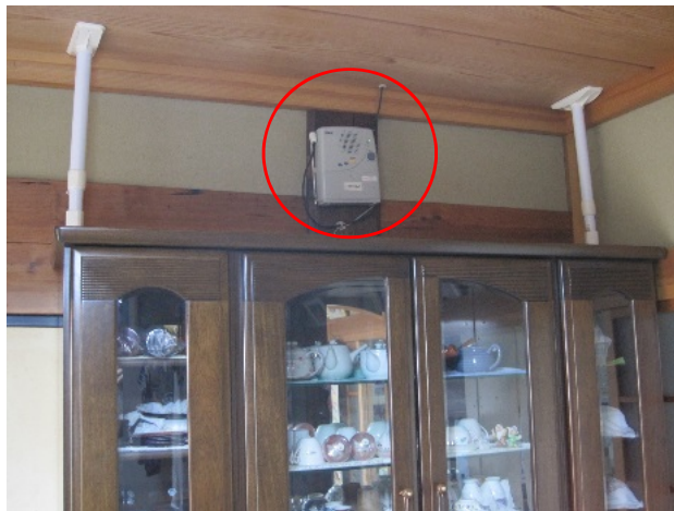
防災無線子機設置状況(一般家庭)
