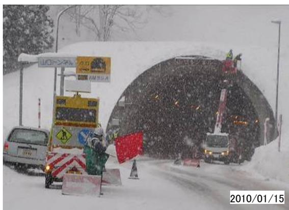
[積雪によりトンネル抗口部での雪庇処理（片側交互通行）]
