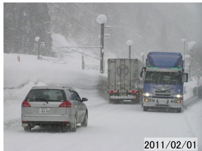
[車道幅員狭小（堆雪）]
