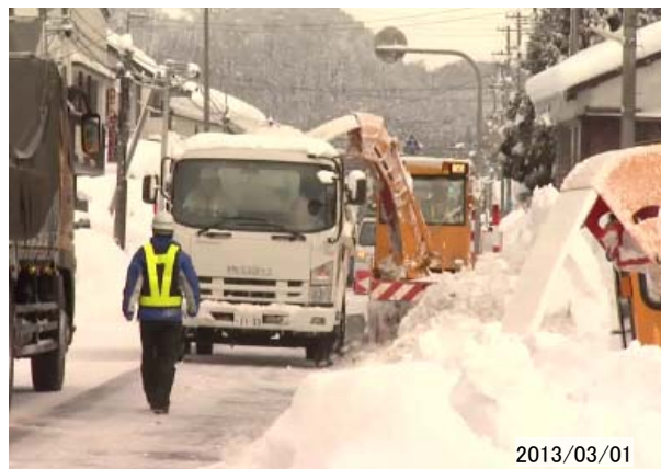
[運搬排雪状況]
