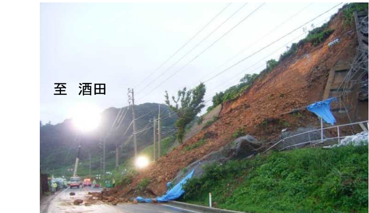
② 土砂崩れの発生状況(鶴岡市小岩川) 平成18年7月13日
