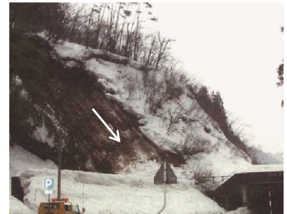
② 雪崩の発生状況(村上市中津原) 平成18年2月15日
