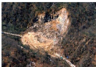
写真1 法面崩壊 (H11.3.10)
