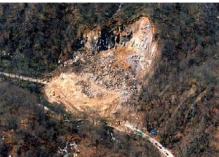
写真1 法面崩壊(H11.3.10)
