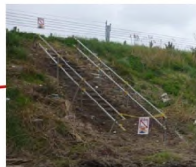
震災後、名取IC～仙台若林JCT周辺の5箇所に、津波時の避難に活用できる仮設階段を暫定的に設置（設置時期：平成23年5月）
