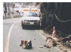
図4 国道121号の落石状況
