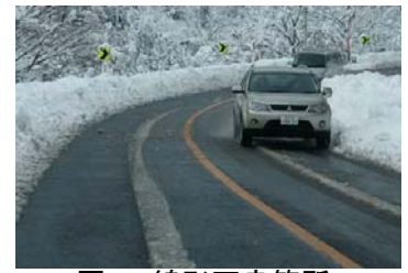
図6 線形不良箇所
