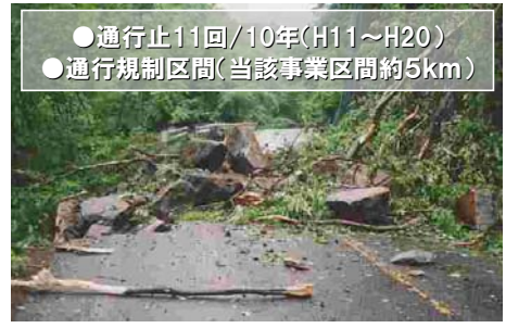
図4 土砂崩れによる通行止(H18.6、約1ヶ月)
