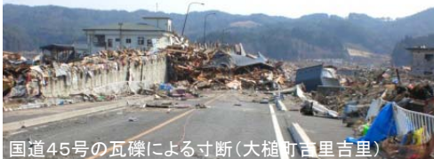
国道45号の瓦礫による寸断(大槌町吉里吉里)
