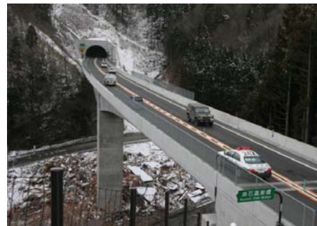
図9 高架で津波被害を免れた釜石山田道路
