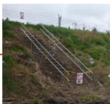
震災後、名取IC～仙台若林JCT周辺の5箇所に、津波時の避難に活用できる仮設階段を暫定的に設置(設置時期:平成23年5月)
