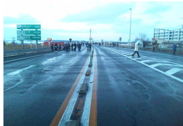
避難状況(仙台港北IC付近)
