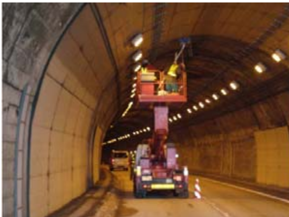
トンネル点検
