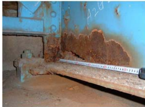
鋼材の腐食
