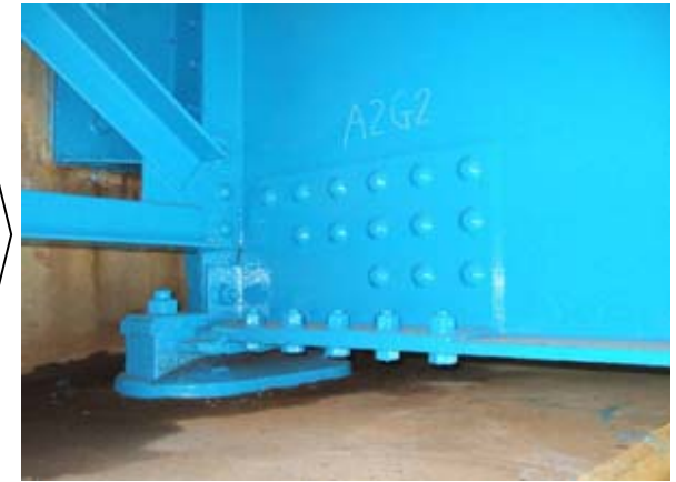
塗装塗替と当て板補強
