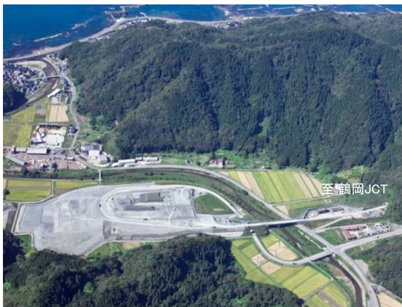
建設中の温海IC
