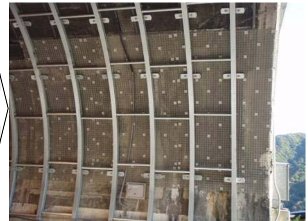
H鋼とネットによる補修
