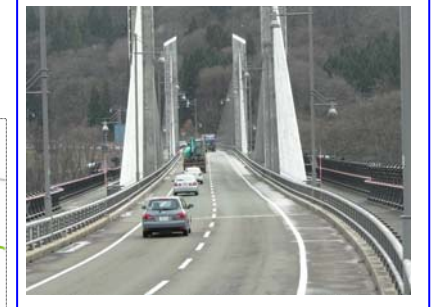
▲(県)あきた北空港西線(翔鷹大橋)
