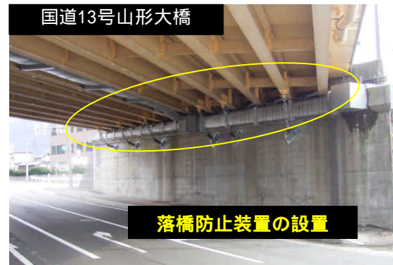
橋梁補強の実施状況
