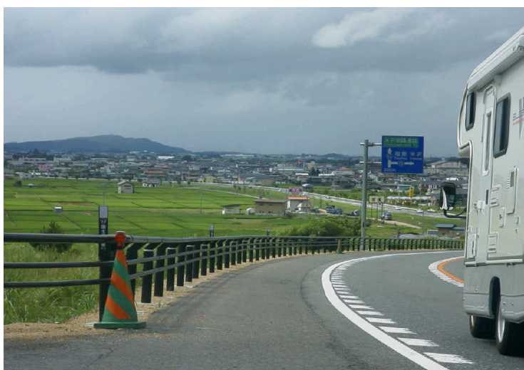
景観に配慮した防護柵：一般国道13号(山形県南陽市)
