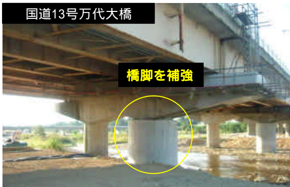
橋梁補強の実施状況
