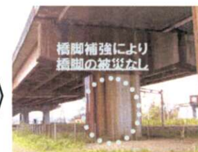
新潟県中越地震(震度7) (長岡市十日町)
