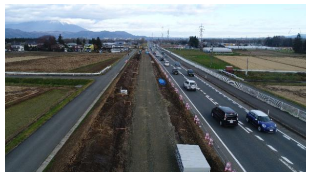
▲4車線化事業推進中の国道46号盛岡西バイパス
