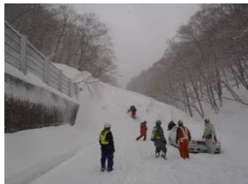
▲国道48号における雪崩発生後の状況(H26.2.15) 出典：東北地方整備局資料
