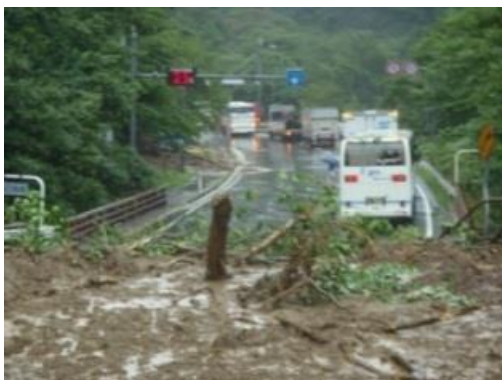
▲国道46号における崩土発生後の状況(H25.8.9) 出典：東北地方整備局資料
